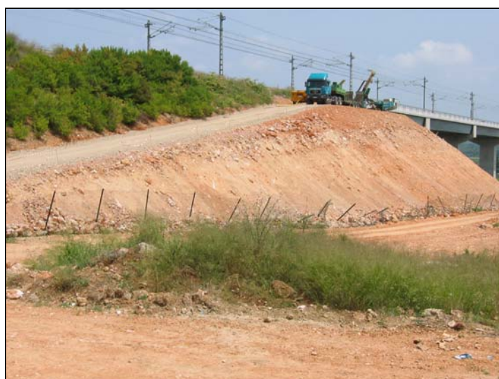
Figura 3. Vista de la banqueta adosada al terraplén para realizar los trabajos de inyección
