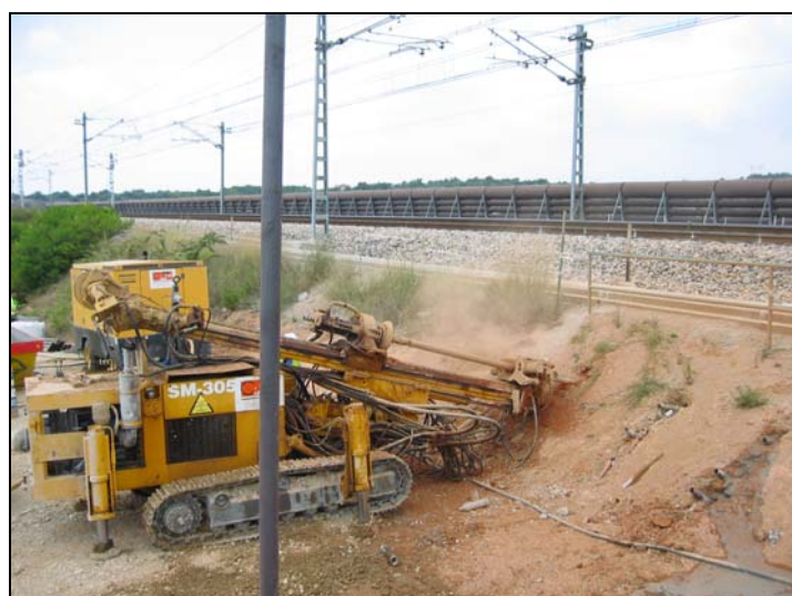
Figura 11. Vista de la perforación de uno de los taladros
