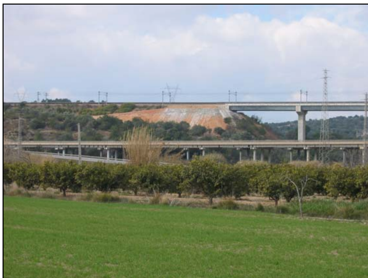
Figura 2. Vista general del terraplén de acceso donde se ha realizado el tratamiento
