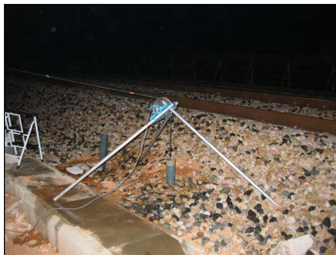
Figura 19. Ejecución de PS-Logging en uno de los sondeos verticales
