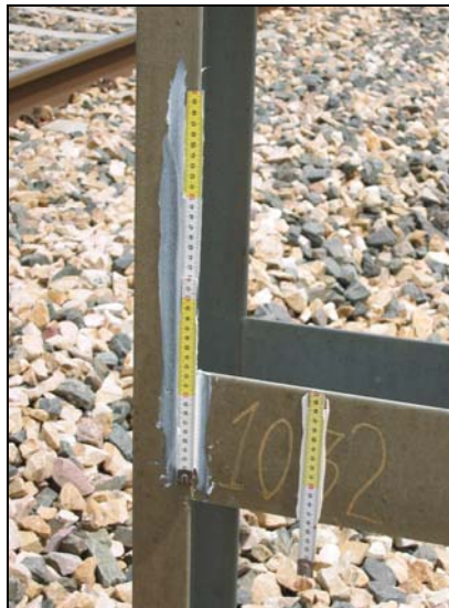
Figura 13. Punto fijo de la nivelación mediante regletas situado en un poste de la catenaria que se encuentra en el tablero del viaducto
