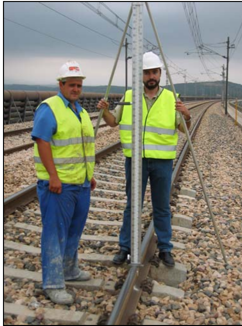
Figura 14. Vista de un instante de la nivelación de alta precisión realizada en la Vía 1.
