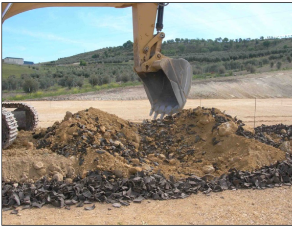
Fotografía 1: Ejecución de las bandas de prueba de NFU mezclado con suelo
