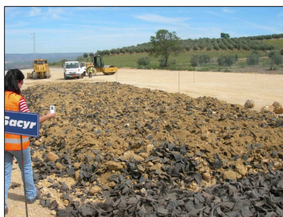
Fotografía 1: Ejecución de las bandas de prueba de NFU mezclado con suelo
