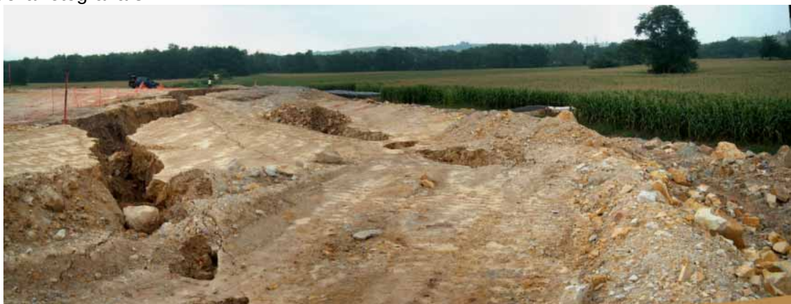
Foto 3.- Aspecto del deslizamiento dos meses después.
