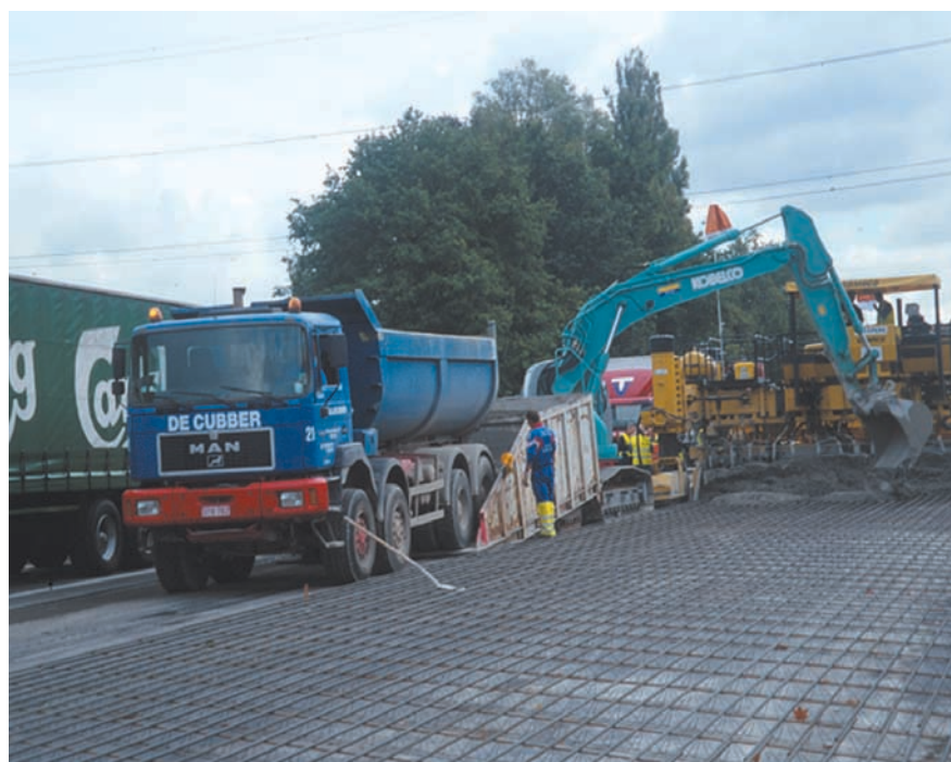
Figura 13. Autopista Bruselas-Ostende: descarga del hormigón.
