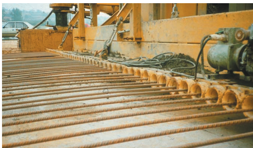
Figura 6. Autovía Oviedo-Pola de Siero: guías en la pavimentadora para posicionamiento de las armaduras longitudinales.
