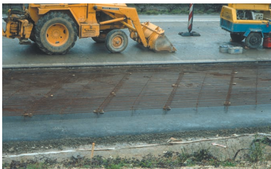
Figura 2. Armaduras longitudinales y armaduras transversales esviadas.
