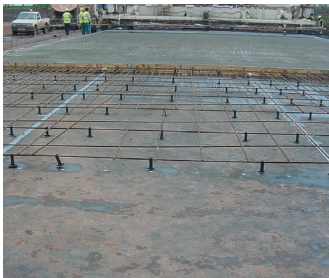
Figura 17 a: Autopista M6 en Birmingham (Reino Unido): Vista de la armadura, soportes e inductores.
