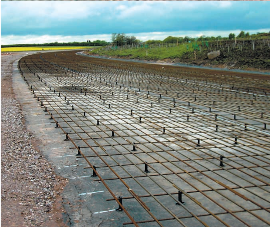
Figuras 18 y 19. Autopista M6: montaje (arriba) y vista (abajo) de la armadura del pavimento.
