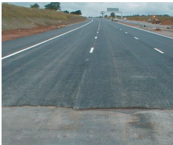
Figura 17 b: Autopista M6 en Birmingham (Reino Unido): Pavimento con armadura.
