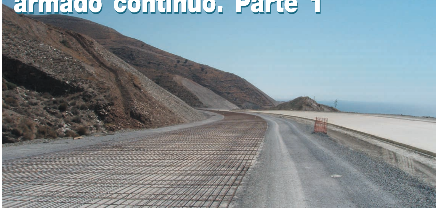
Figura 1. Armadura de pavimento armado continuo.
