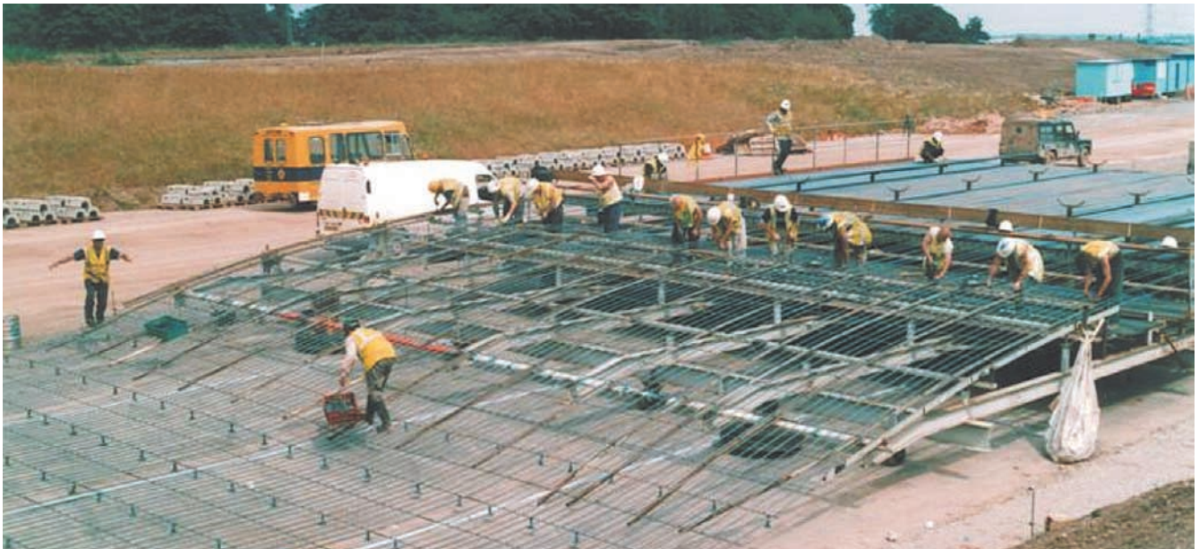
Figuras 18 y 19. Autopista M6: montaje (arriba) y vista (abajo) de la armadura del pavimento.
