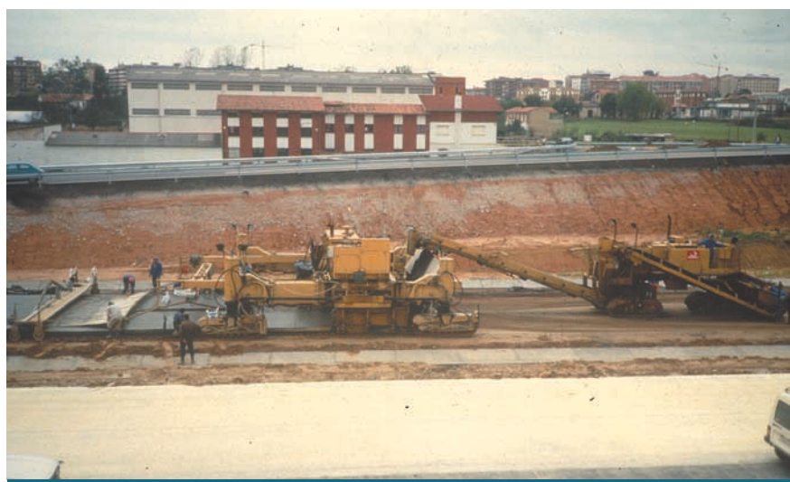
Figura 7. Autovía Oviedo-Pola de Siero: vista de conjunto de equipos para ejecución de pavimento mediante guiado de armaduras.
