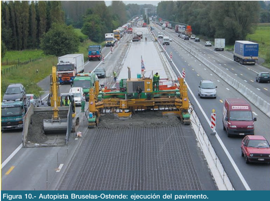
Figura 10.- Autopista Bruselas-Ostende: ejecución del pavimento.
