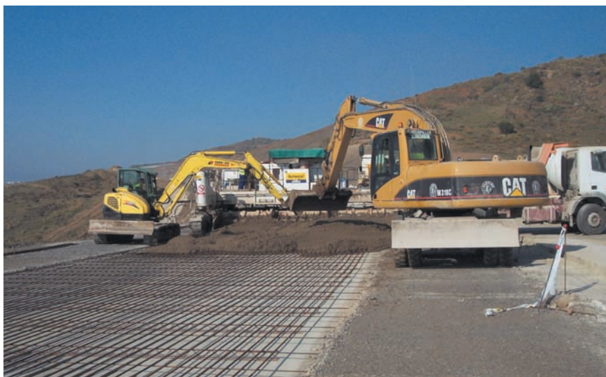
Figura 4. Ejecución del pavimento de la autovía Adra-Albuñol.
