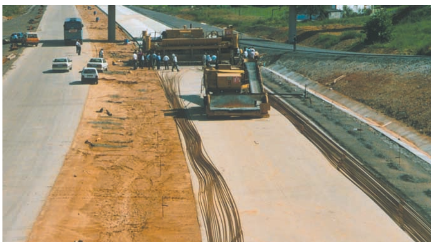
Figura 5. Autovía Oviedo-Pola de Siero: armaduras longitudinales colocadas en los bordes de la capa de base.
