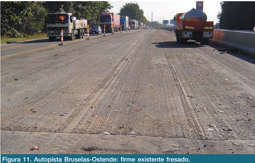
Figura 11. Autopista Bruselas-Ostende: firme existente fresado.
