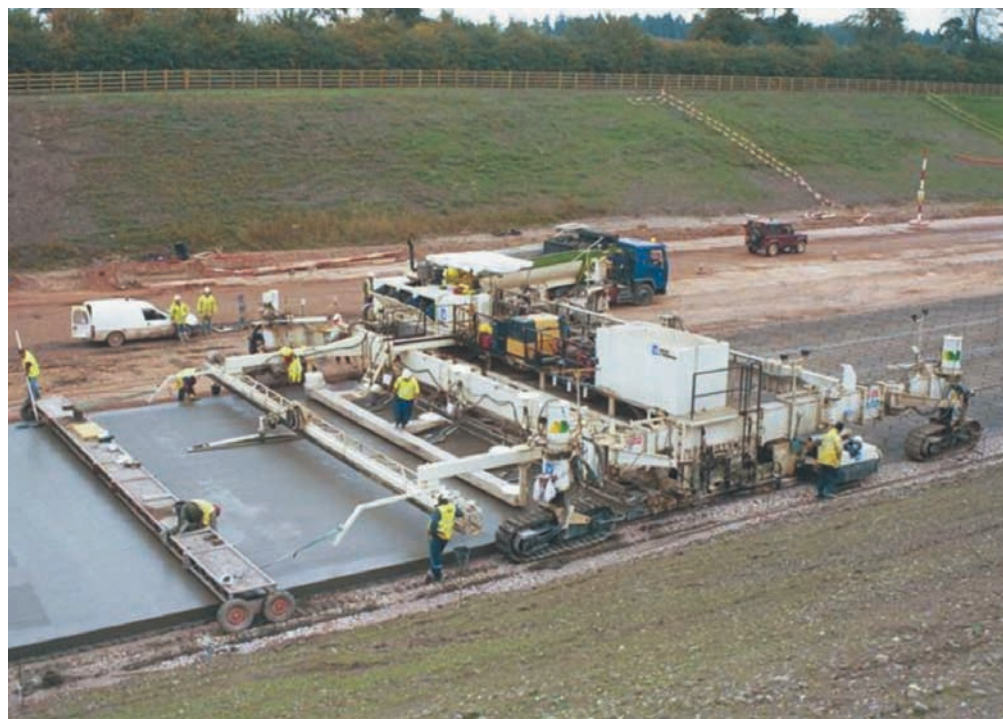
Figura 20. Autopista M6. Pavimentadora.
