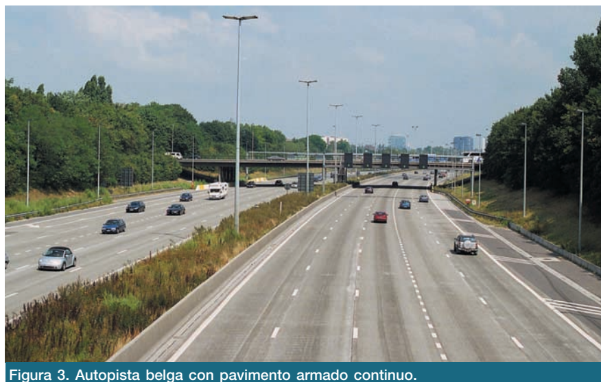
Figura 3. Autopista belga con pavimento armado continuo.
