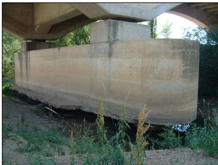
Figura nº 3. Cimentación profunda observada en una inspección de cauce
