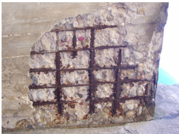
Figuras 23 y 24. Detalles de corrosión generalizada por carbonatación del hormigón.
