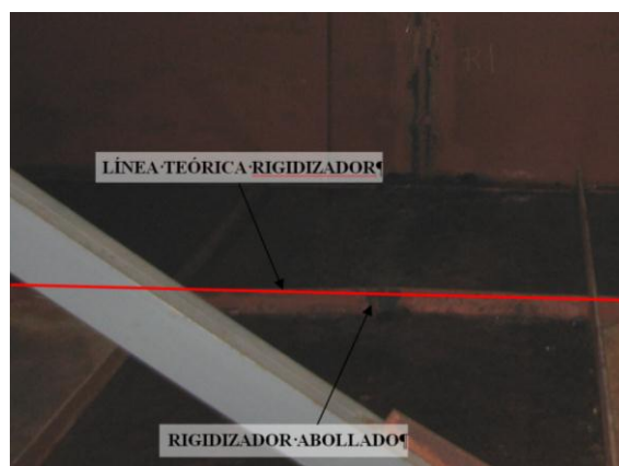
Figuras 44 y 45. Ejemplos de abolladura de panel metálico por compresiones excesivas.
