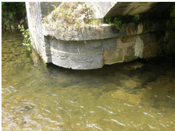
Figuras 6 y 7. Lavado de llagas en muro de frente de mampostería, llegando a arrancar parte de los mampuestos, produciendo el descalce parcial del muro, produciéndose el correspondiente giro y apertura de grieta en la bóveda.
