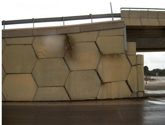
Figuras 60 y 61. Problemas en muros de suelo reforzado por asiento del terraplén, produciendo la rotura parcial de placas, así como hundimientos locales de la plataforma.
