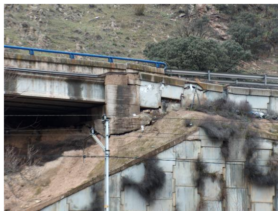
Figuras 60 y 61. Problemas en muros de suelo reforzado por asiento del terraplén, produciendo la rotura parcial de placas, así como hundimientos locales de la plataforma.
