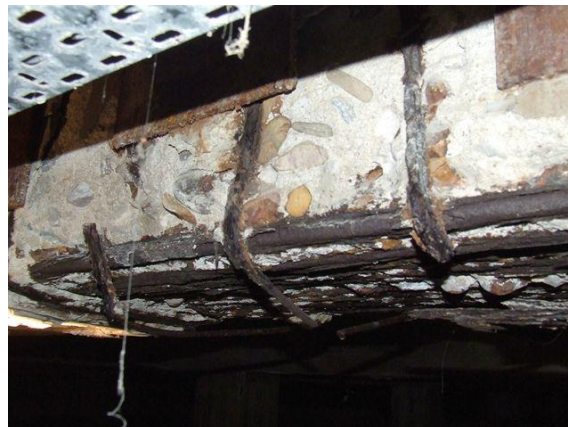
Figuras 23 y 24. Detalles de corrosión generalizada por carbonatación del hormigón.
