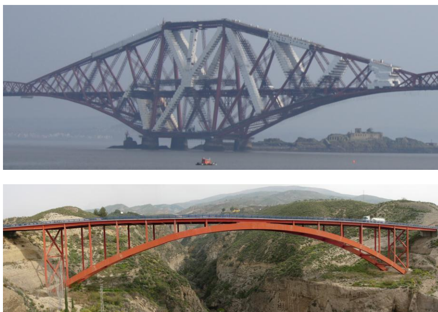
Figuras 48 y 49. Ejemplos de puentes en donde las labores de conservación y mantenimiento de la pintura de protección resultan muy complicadas y caras debido a los medios auxiliares necesarios utilizar. Arriba puente del Firth of Forth y, abajo, puente del Tablate.
