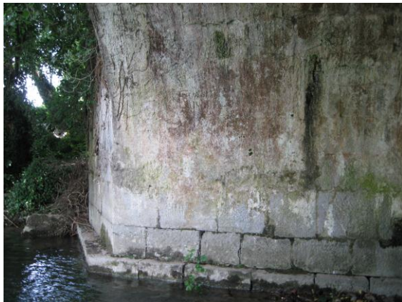
Figuras 10 y 11. Humedades por circulación de agua desde el trasdós de la bóveda a través de las juntas, produciendo el lavado de llagas y la precipitación de sales.
