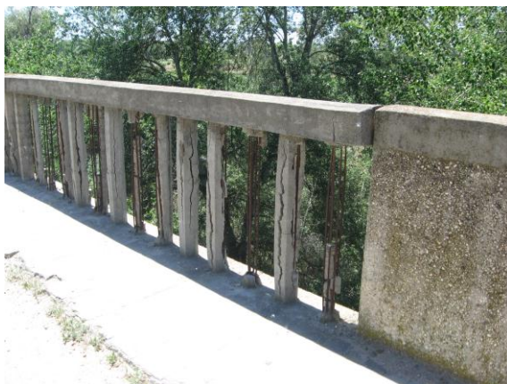
Figuras 62 y 63. Deterioro de barandillas y pretilas de hormigón armado.
