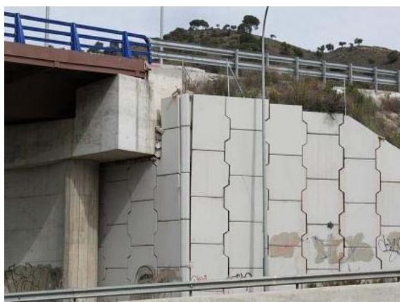
Figuras 58 y 59. Movimientos en muros de suelo reforzado por circulación de agua por su interior, produciendo el lavado de finos y los consiguientes asientos y acompañamientos de las placas.
