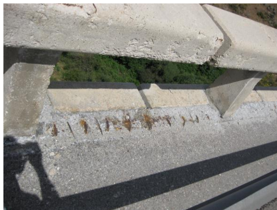
Figuras 62 y 63. Deterioro de barandillas y pretilas de hormigón armado.
