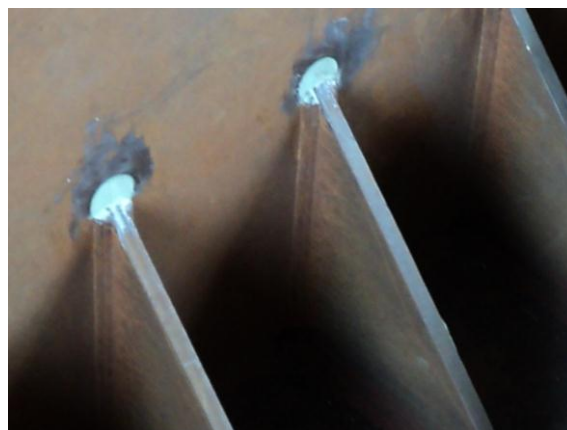
Figura 51. Utilización de mástic para el sellado de ojales en elementos inaccesibles metálicos, creando recintos estancos y protegidos, por tanto, contra la corrosión atmosférica.
