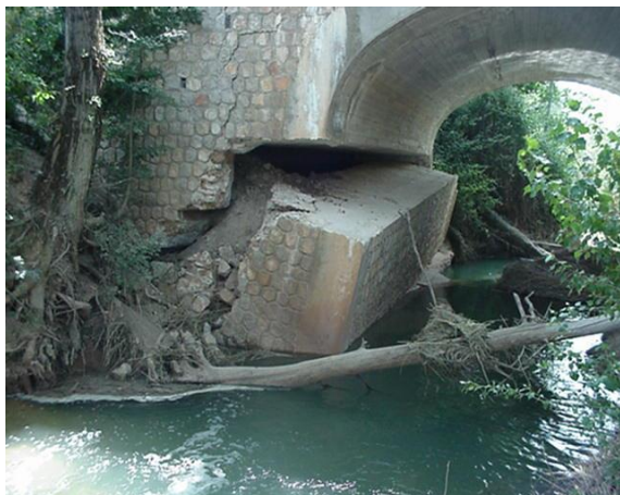
Figuras 8 y 9. Colapso de estructura por socavación en cimentación rígida. La rigidez de la cimentación y el monolitismo del muro de frente han ido “ocultando” los daños de erosión y socavación del puente hasta que se ha producido su colapso total.
