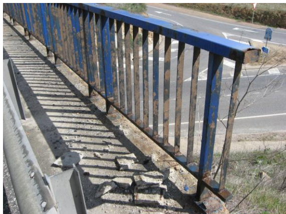
Figuras 64 y 65. Deterioro de sistemas de contención metálicos.
