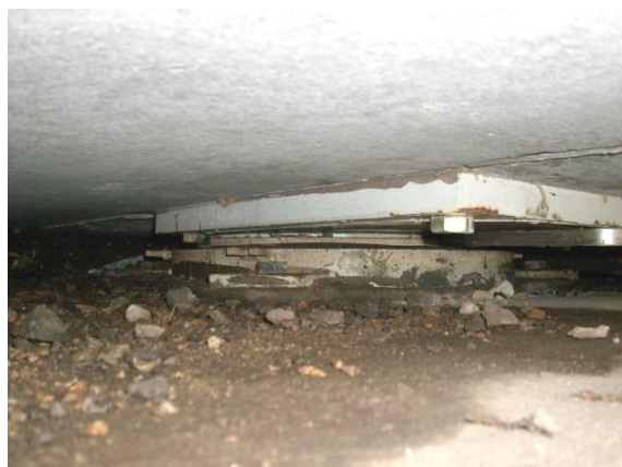
Figura 66. Agotamiento de la carrera de la bandeja deslizante.
