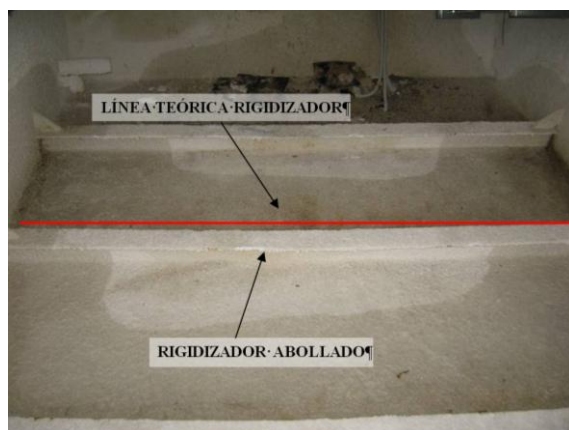
Figuras 44 y 45. Ejemplos de abolladura de panel metálico por compresiones excesivas.
