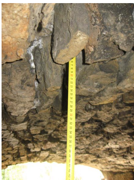
Figura 12. Lavado de llagas por circulación de agua.
