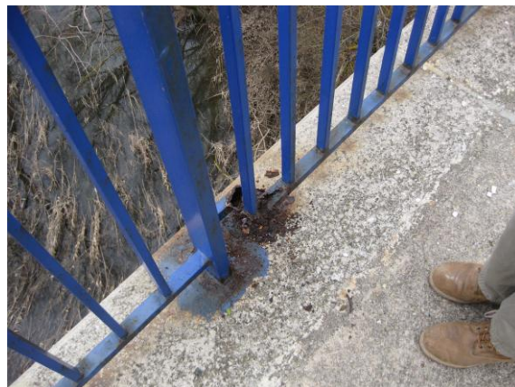
Figuras 64 y 65. Deterioro de sistemas de contención metálicos.
