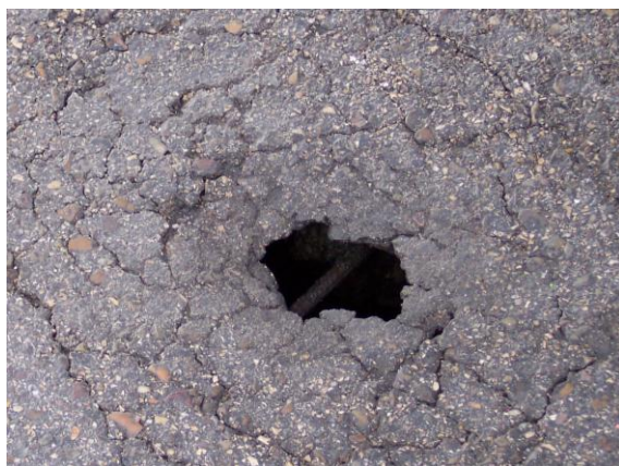
Figuras 33 y 34. Rotura de losa de puente con aligeramientos huecos, con la consiguiente entrada de agua al interior de la losa. A la derecha, taladro realizado para evacuación del agua en uno de los aligeramientos.
