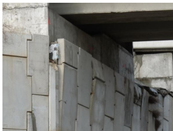
Figuras 58 y 59. Movimientos en muros de suelo reforzado por circulación de agua por su interior, produciendo el lavado de finos y los consiguientes asientos y acompañamientos de las placas.
