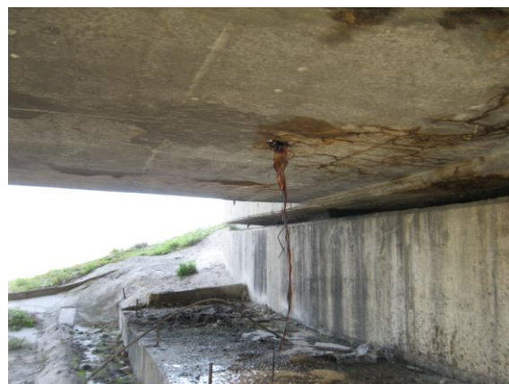
Figuras 33 y 34. Rotura de losa de puente con aligeramientos huecos, con la consiguiente entrada de agua al interior de la losa. A la derecha, taladro realizado para evacuación del agua en uno de los aligeramientos.
