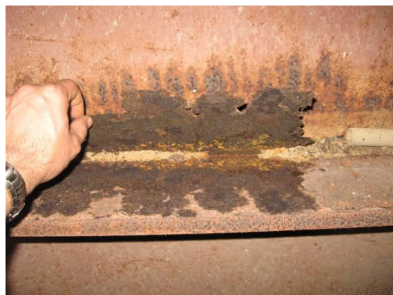
Figuras 52 y 53. Interior de un cajón mixto de acero corten con importantes filtraciones de agua, habiendo degenerado en el deterioro del sistema de pintura y la oxidación del acero autopatinable, al no ser capaz éste de generar la capa de pátina debido a la falta de ventilación, la alta humedad y condensación interior del cajón.
