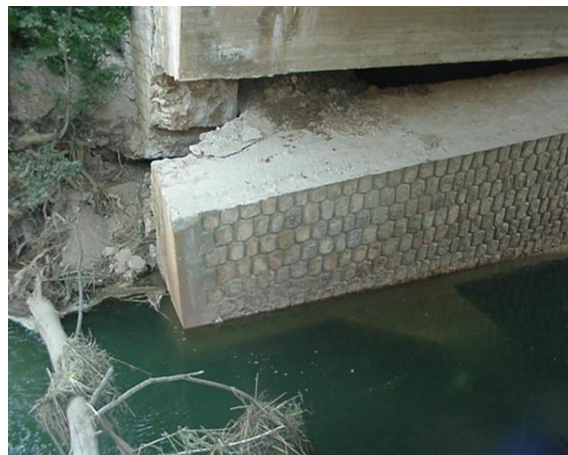
Figuras 8 y 9. Colapso de estructura por socavación en cimentación rígida. La rigidez de la cimentación y el monolitismo del muro de frente han ido “ocultando” los daños de erosión y socavación del puente hasta que se ha producido su colapso total.
