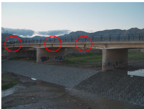
Figura 29. Puente de hormigón armado con apoyos a media madera.
