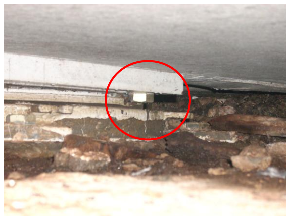
Figura 66. Agotamiento de la carrera de la bandeja deslizante.
