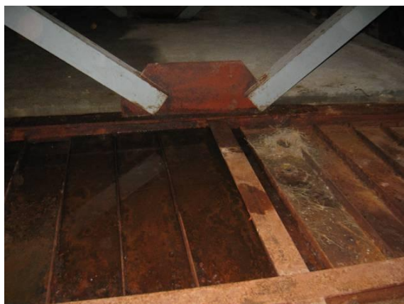
Figuras 52 y 53. Interior de un cajón mixto de acero corten con importantes filtraciones de agua, habiendo degenerado en el deterioro del sistema de pintura y la oxidación del acero autopatinable, al no ser capaz éste de generar la capa de pátina debido a la falta de ventilación, la alta humedad y condensación interior del cajón.
