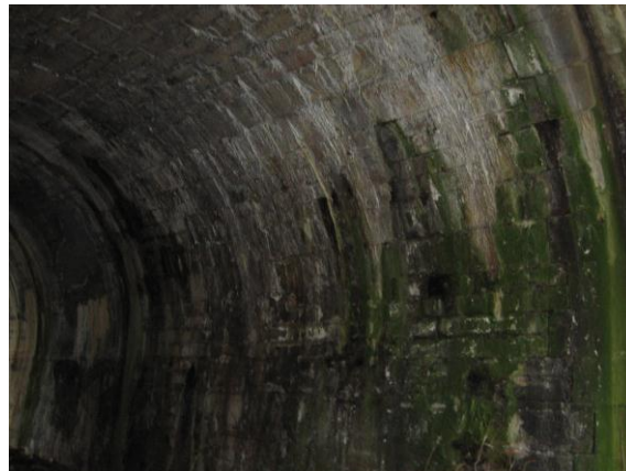
Figuras 10 y 11. Humedades por circulación de agua desde el trasdós de la bóveda a través de las juntas, produciendo el lavado de llagas y la precipitación de sales.
