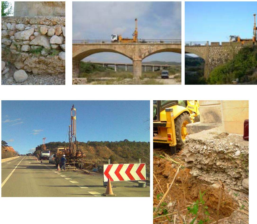
En ocasiones el sondeo realizado se utiliza para introducir una cámara por el sondeo y poder observar las eventuales oquedades detectadas:
