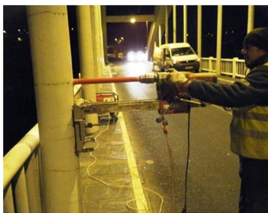
En la extracción de probetas testigo será fundamental programar los trabajos para poder obtener probetas de esbeltez (L/D) superior a 1 y diámetro al menos dos veces superior al tamaño máximo de árido.
