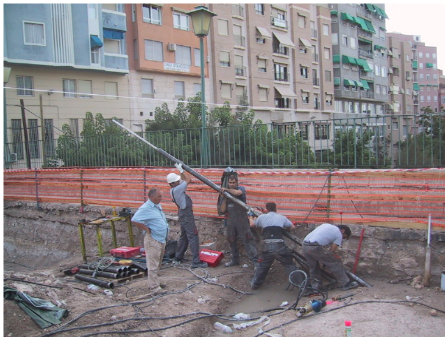
Figura 20.-Perforación e introducción de barras de refuerzo
