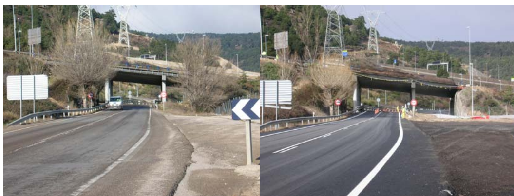
Figura 5.- Ramal 3. Variante de Guadarrama Muro "soil mailing" para evitar el descalce de la subestructura
