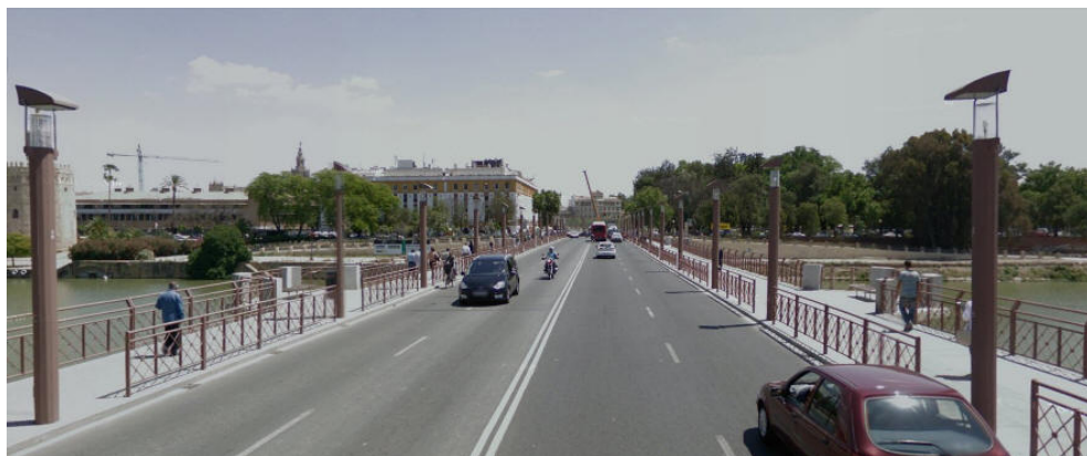
Figura 14.-Vista de la plataforma rehabilitada
