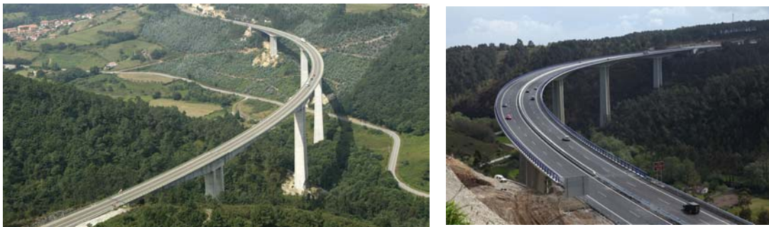
Figura 3.- Viaducto de San Pedro de la Ribera Ensanche del tablero (estructura original y ampliada)
