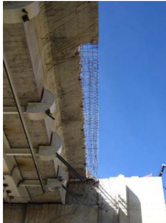
Figura 8.-Viaducto de San Pedro de la Ribera Conexión del ensanche del voladizo superior
