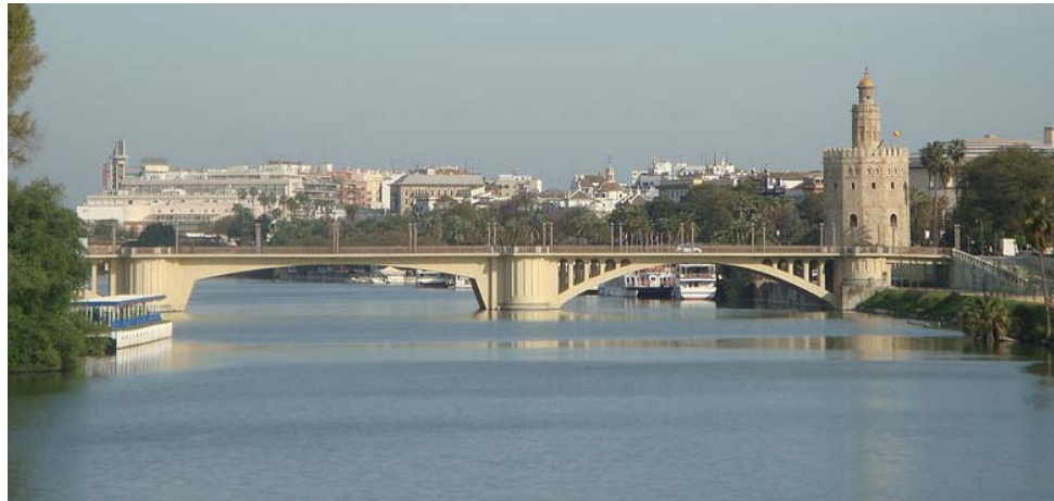
Figura 13.-Vista general del Puente de San Telmo
