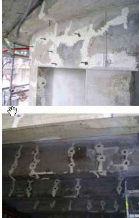
Figura 15.-Sellado e inyección de fisuras
