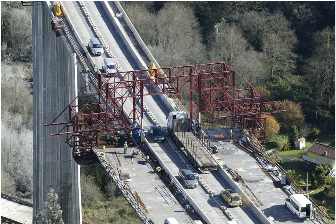
Figura 4.- Viaducto de San Pedro de la Ribera Afección al tráfico durante las obras
