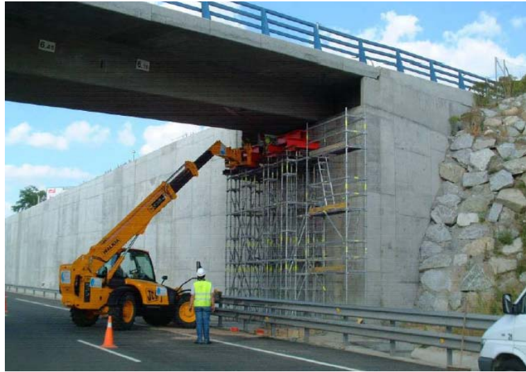
Figura 7.- Paso Superior de Autovía Apeo provisional para soporte de gatos para sustitución de apoyos.
