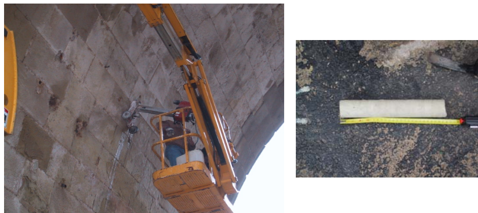
Figura 1.- Puente de Santa Teresa (Elche) Investigación del espesor de la rosca del arco
