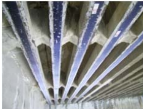
Figura 16.-Refuerzo con láminas de fibra de carbono
