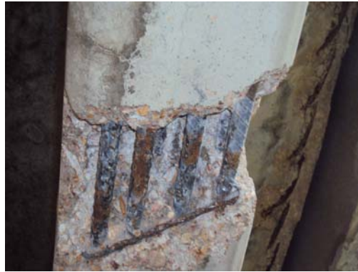
Figura 2.- Paso Superior de Autopista Calas en nervios para conocer la posición y cuantía de la armadura
