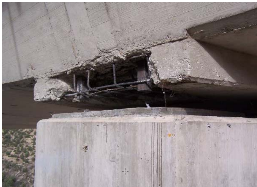
Figura 10.-Apoyo de viaducto Demolición de la zona de apoyo para sustitución de un aparato de apoyo tipo POT
