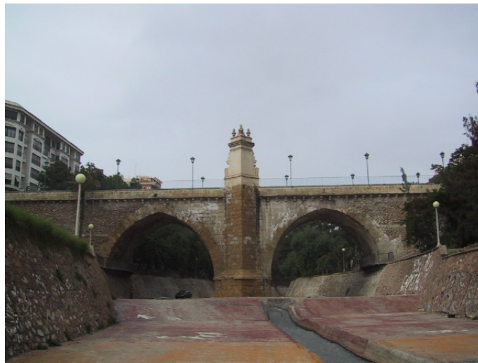
Figura 19.-Puente de Santa Teresa sobre el río Vinalopó
