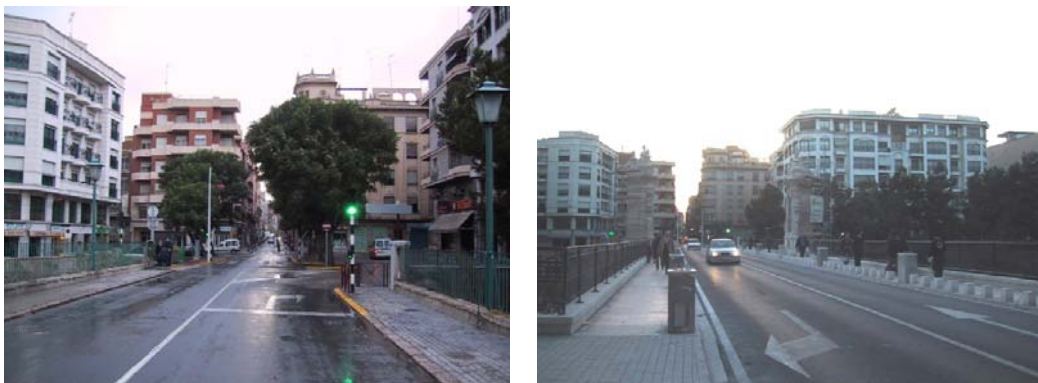
Figura 22.-Plataforma antes y después de la actuación
