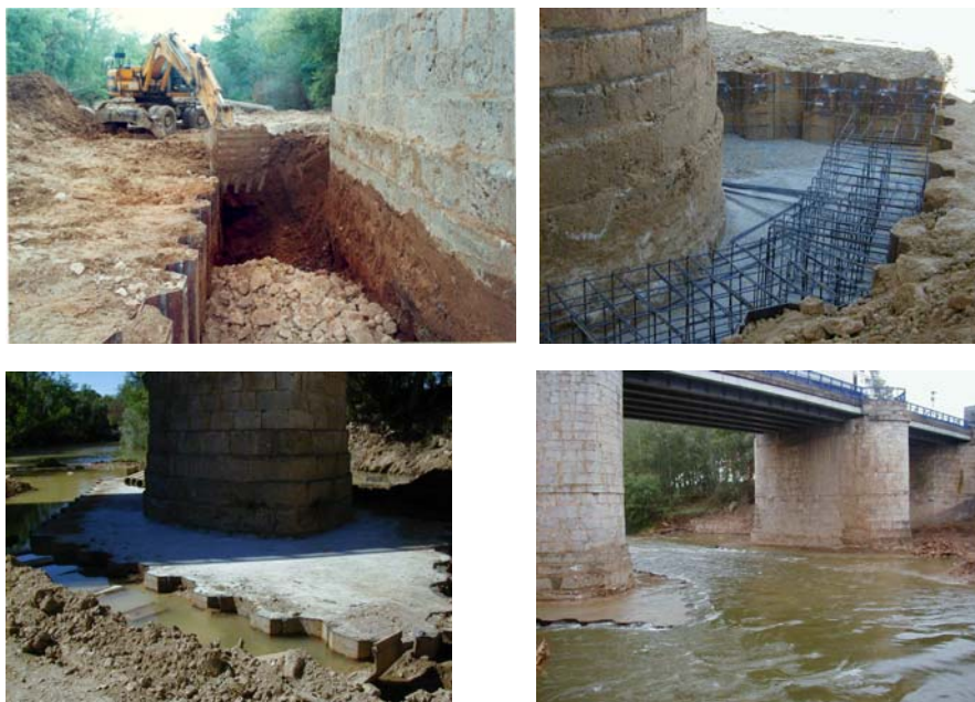
Figura 18.-Puede de Boecillo. Algunas imágenes del recalce
