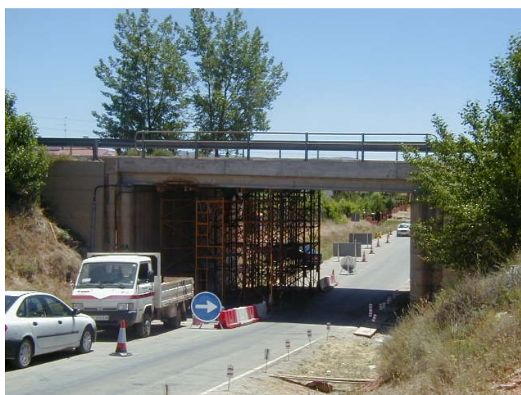
Figura 6.-Paso Inferior en Teruel Colocación de cimbra pero permitiendo el paso bajo el tablero a reparar.
