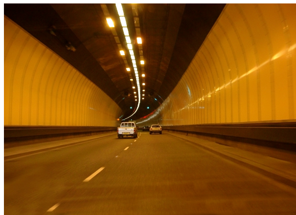
Figura 11. Túnel de paso de vehículos. En los sistemas actuales no hay control parametrizado de los compuestos peligrosos.
