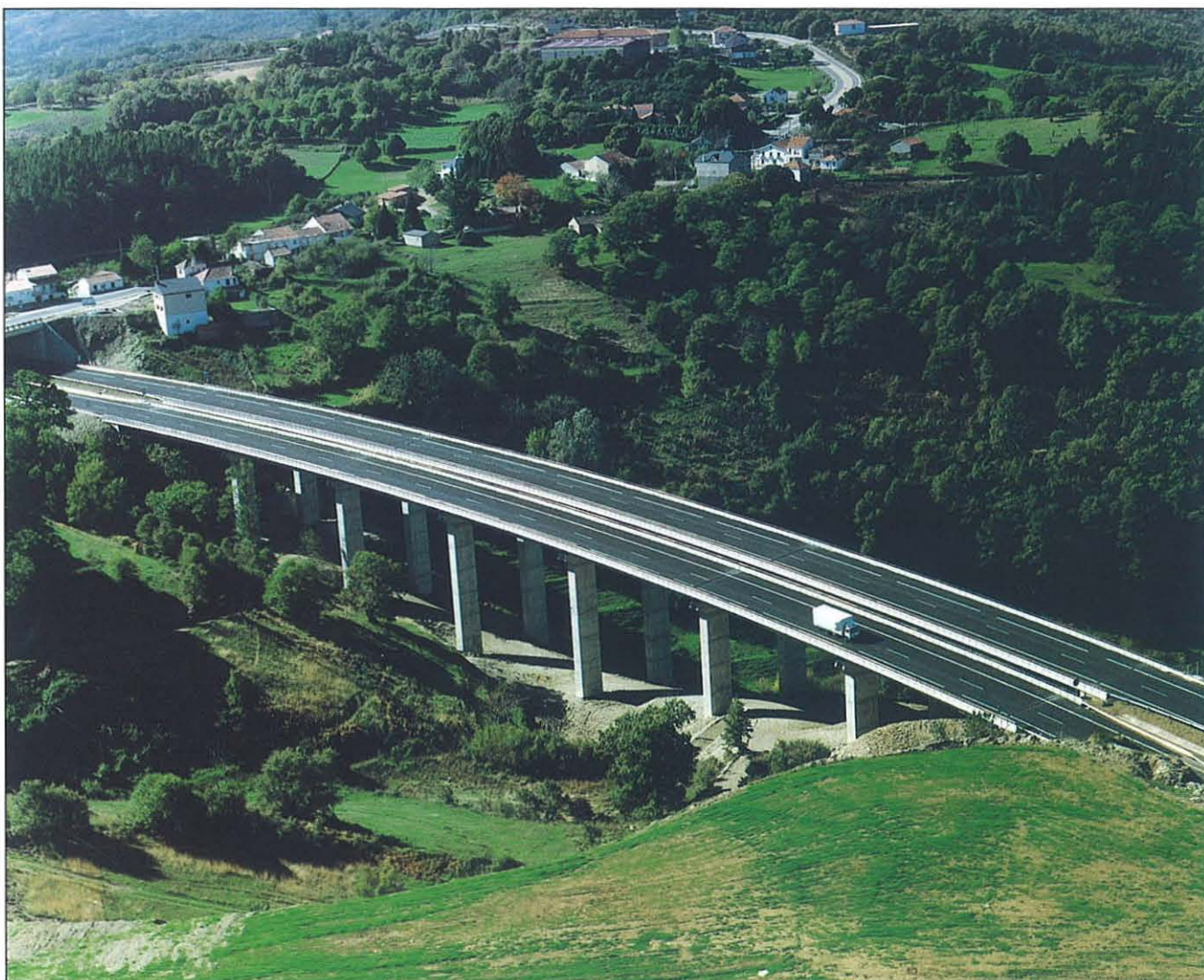
Viaducto de Ventas de la Barrera, de 273 m de longitud.
