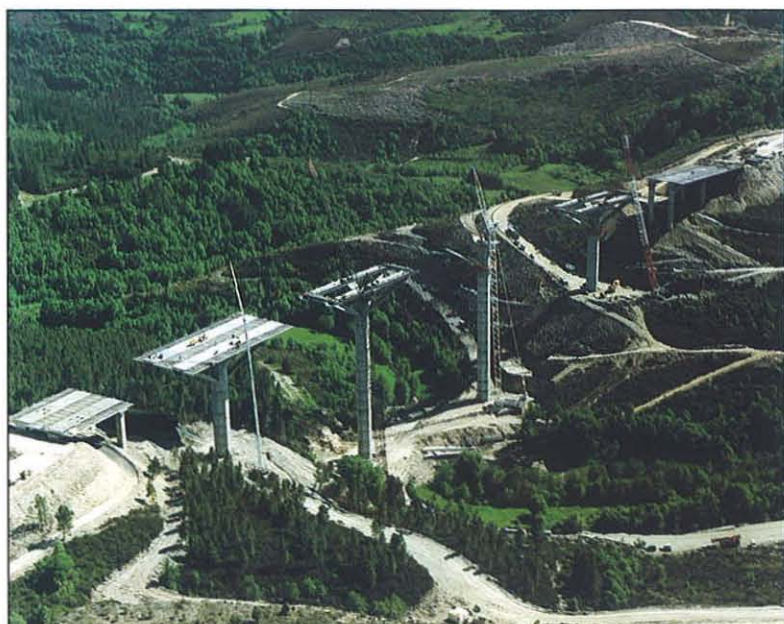
Viaducto sobre el Río Mente en fase de construcción.
