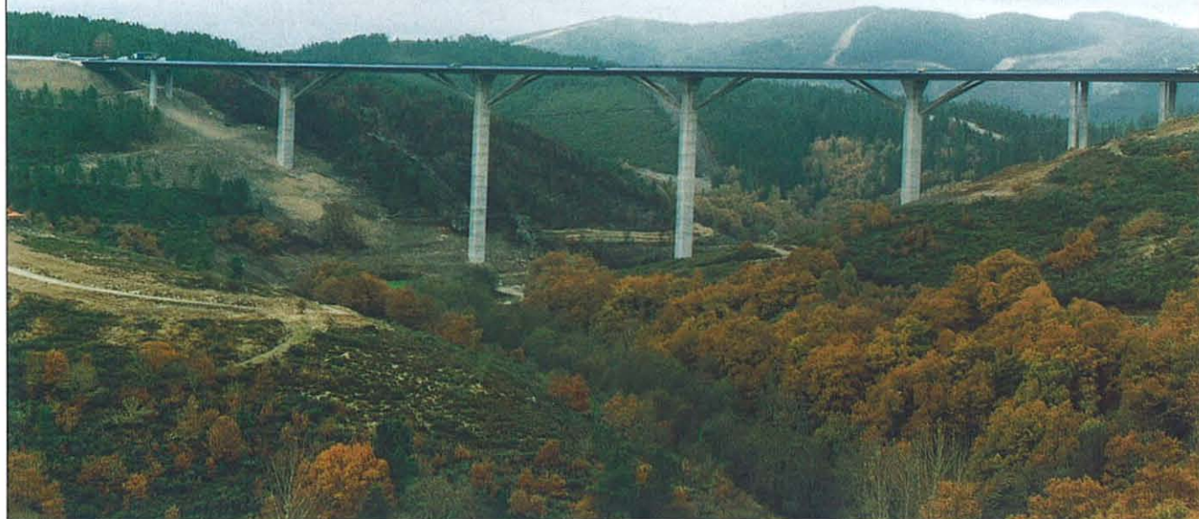
Viaducto sobre el río Mente.
