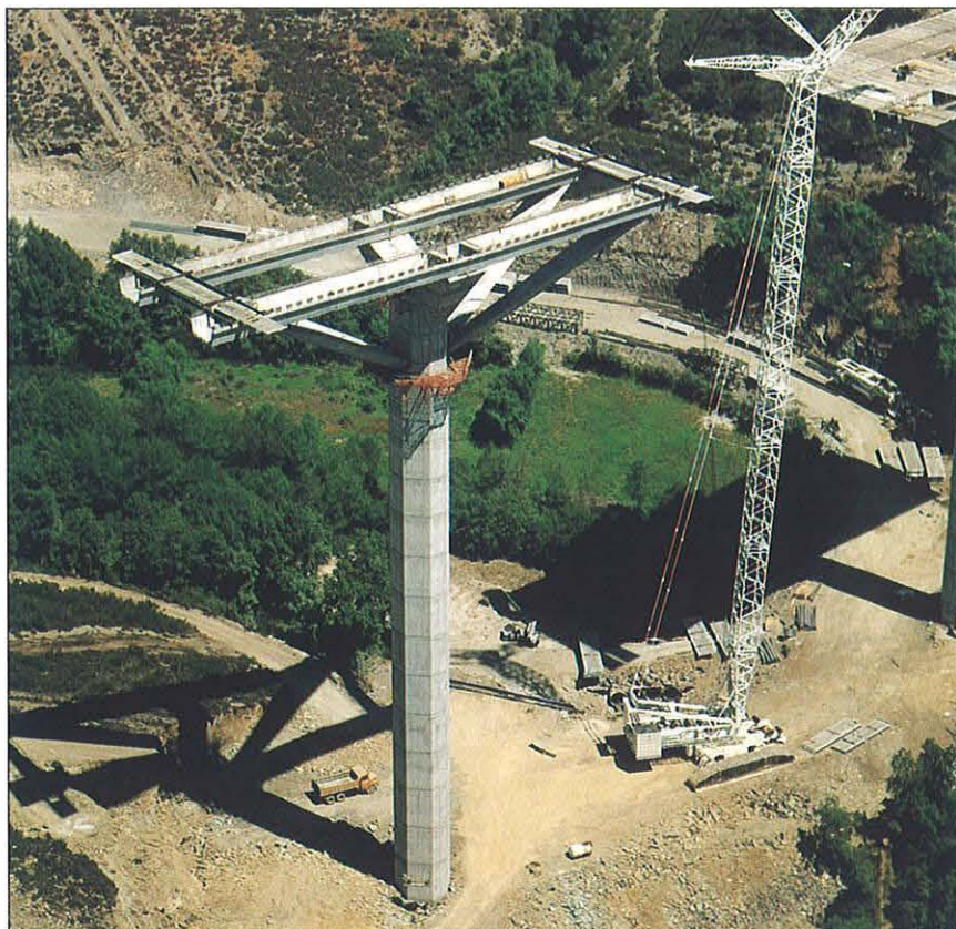
El viaducto sobre el río Mente tiene una longitud de 480 m.
