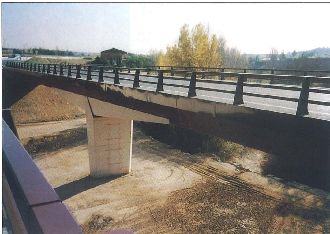
La obra incluye la construcción de cuatro nuevos puentes y la rehabilitación y conservación del puente del Retamar.
