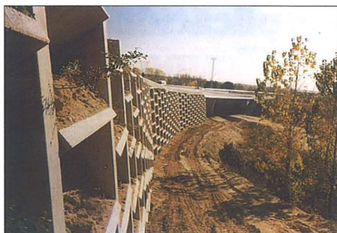
Puente sobre el barranco de Itamén. En él, se aprecia la disposición de un muro verde con jardineras de 80 m de longitud.
