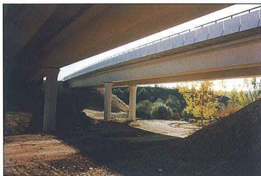
Detalle de estructuras y pilas.
