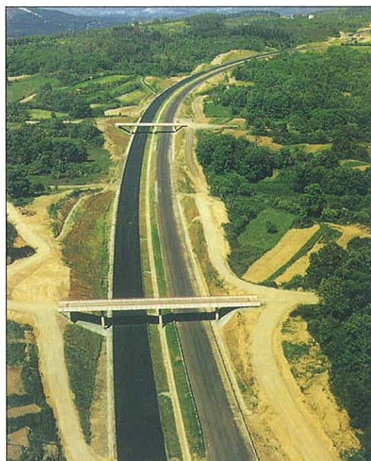
Vista general de pasos superiores.
