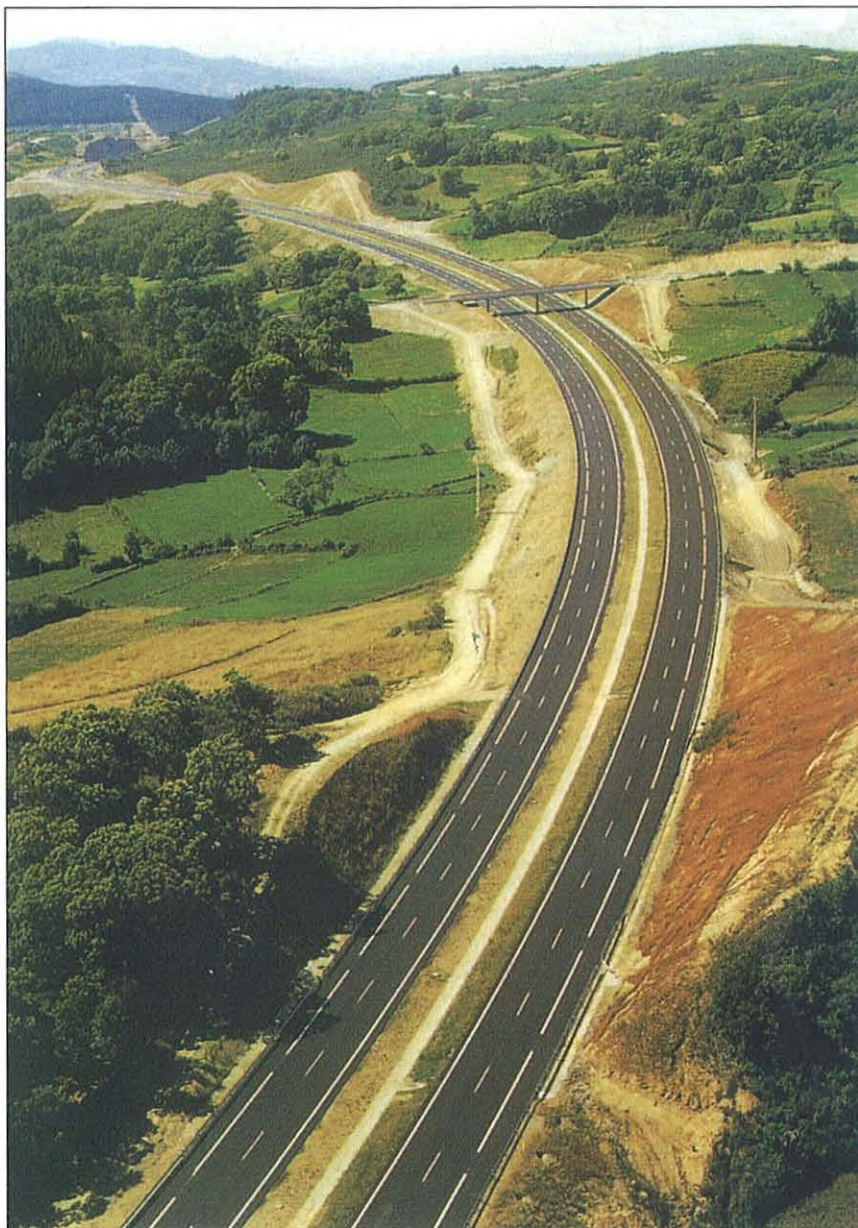
Vista general de la obra.
