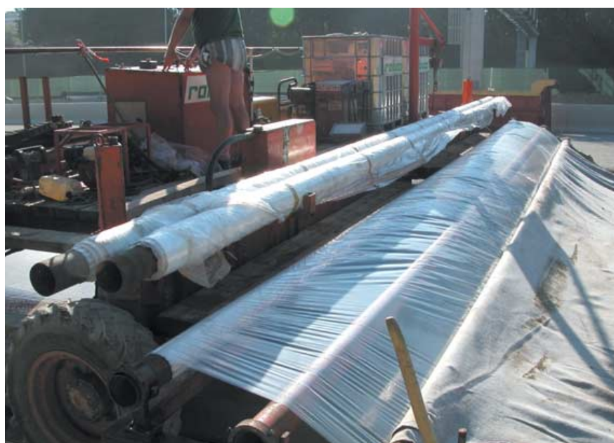
Figura 29 a y b. Circunvalación de Amberes: extensión de lámina de plástico para protección del hormigón fresco y del retardador del fraguado.
