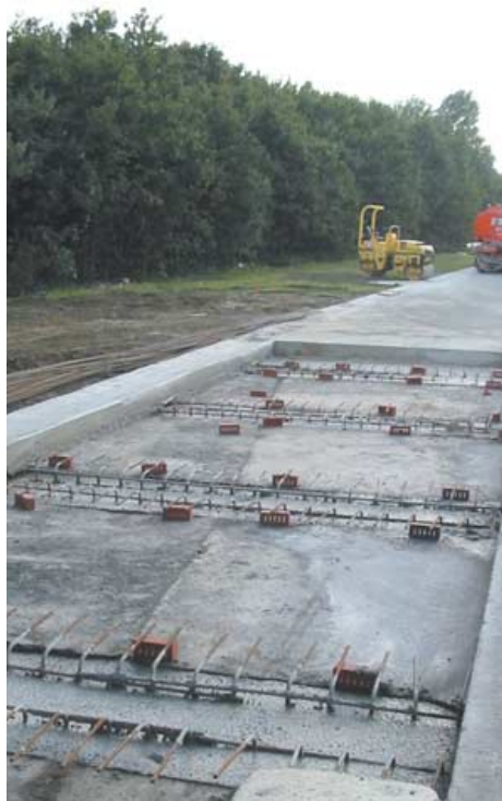
Figura 26 a, b y c: Circunvalación de Ambers: anclaje con rastrillos.
