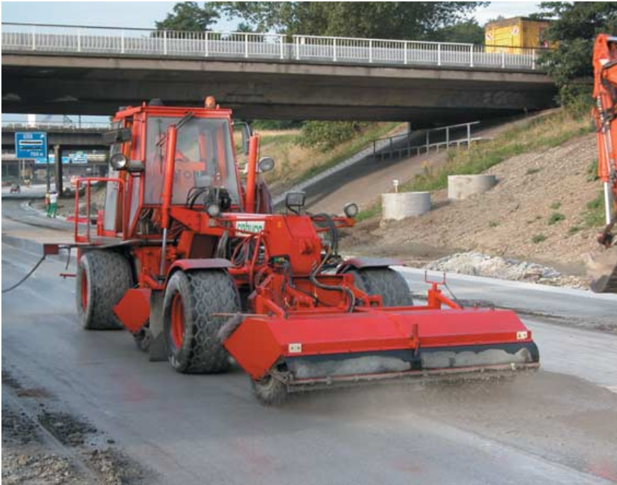
Figura 30. Circunvalación de Amberes: eliminación del mortero superficial.
