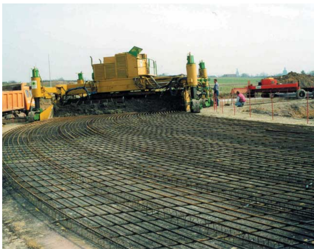
Figura 39. Ejecución de pavimento continuo de hormigón armado en glorieta.
