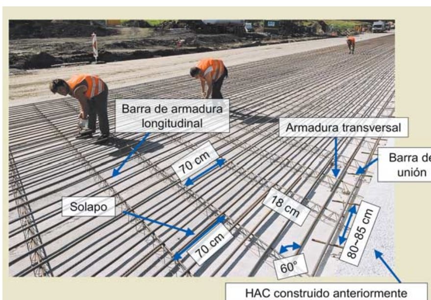
Figura 24. Circunvalación de Amberes: armaduras.
