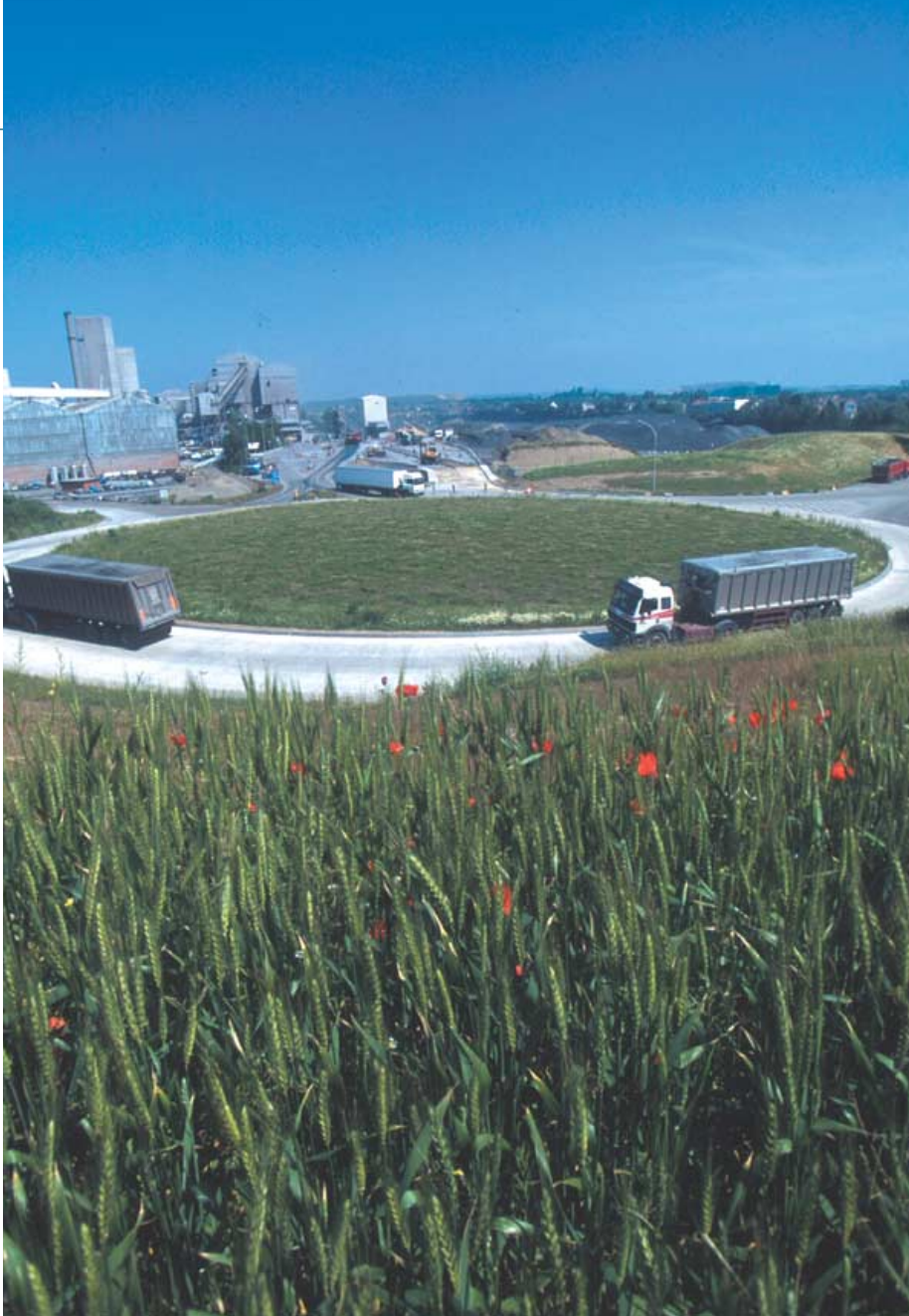
Figuras 37. Glorieta con pavimento de hormigón.
