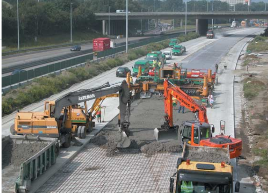
Figura 28. Circunvalación de Amberes: ejecución del pavimento.
