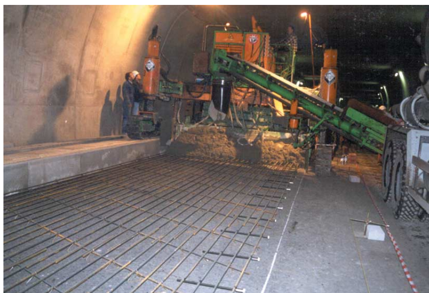
Figura 34. Túnel de Cointe (Lieja): hormigonado de la primera franja.
