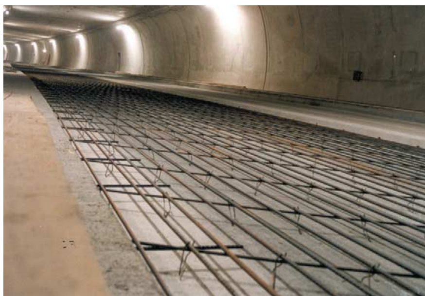
Figura 35. Túnel de Cointe (Lieja): armaduras de la segunda franja.
