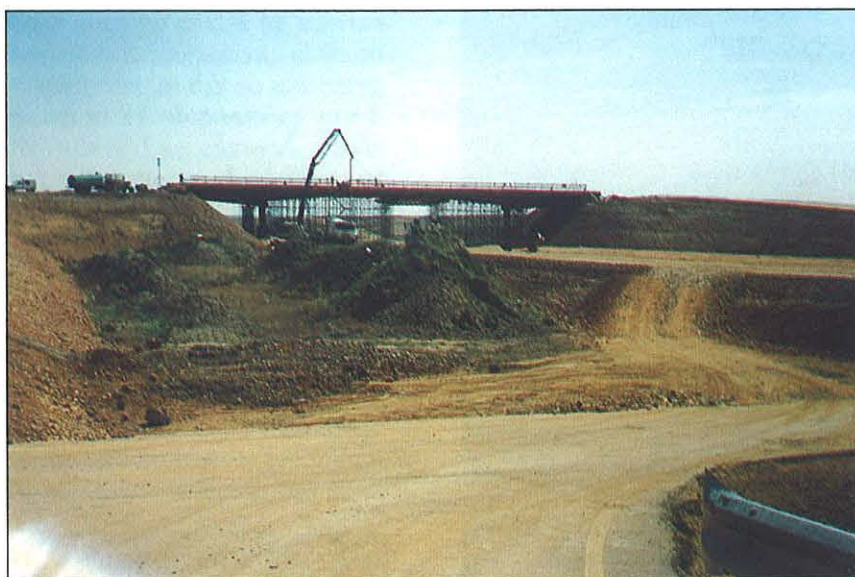
Paso superior en fase de construcción.
