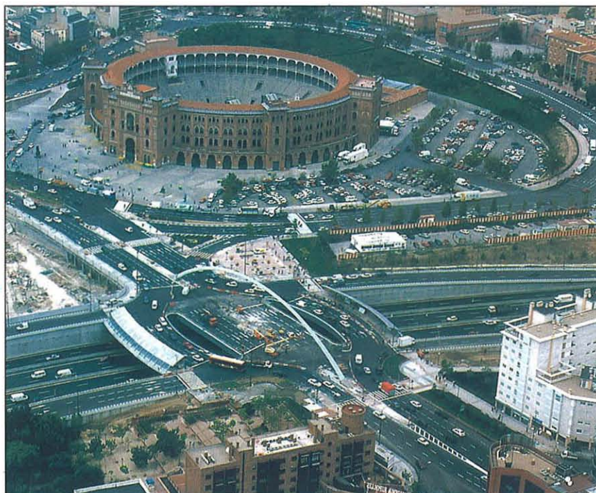
Lo nuevo y lo viejo: el nuevo Puente de Ventas y la plaza de toros.
