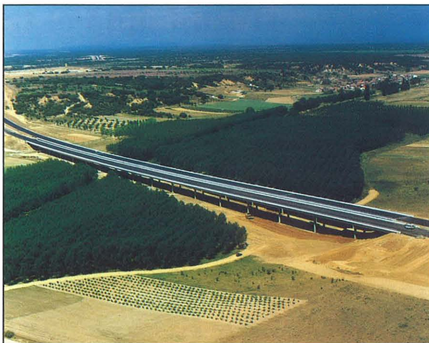
A lo largo del itinerario se han construido viaductos sobre los arroyos Regato y Valchano, y sobre el río Negro.
