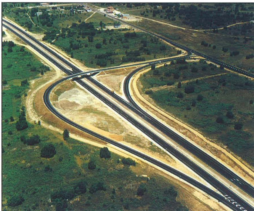
Dos semienlaces y uno completo se han dispuesto a lo largo del tramo inaugurado.
