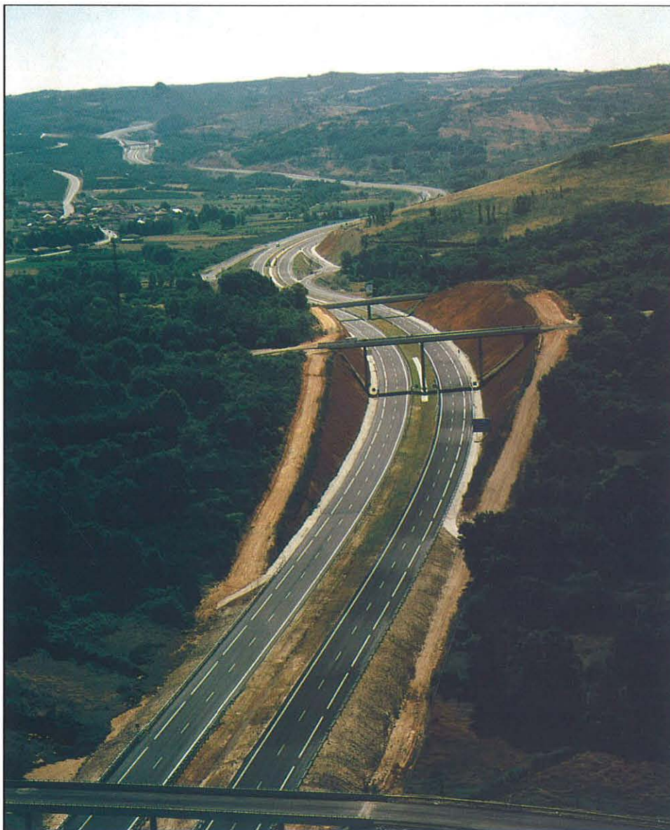
A lo largo de este tramo, se han construido un total de 22 estructuras entre pasos inferiores y superiores.
