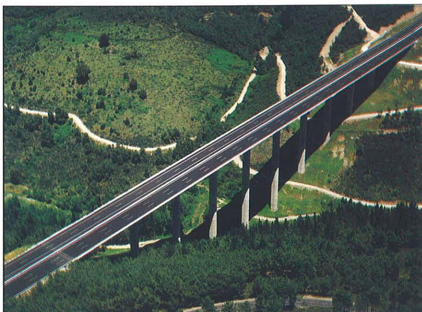
A lo largo del tramo se han construido cinco viaductos.
