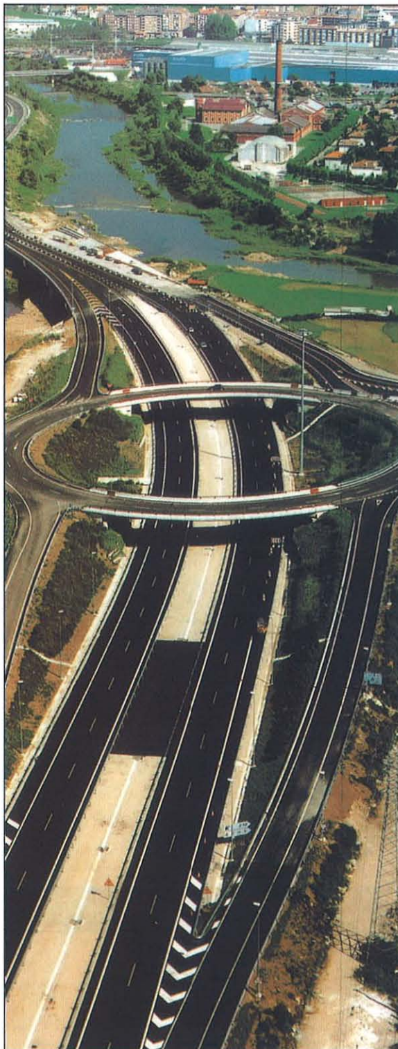
Con la construcción de este tramo se finaliza el itinerario Torrelavega-Cabezón de la Sal.
