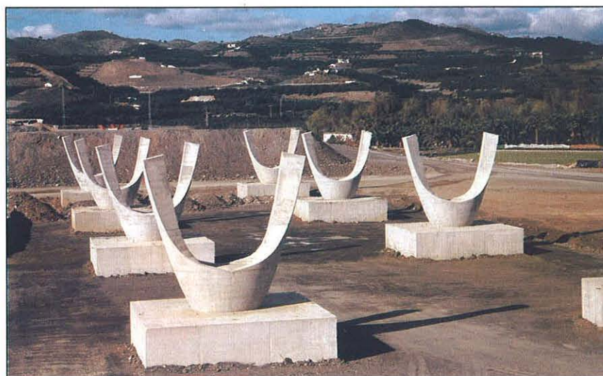
Se han construido un total de cuatro viaductos para salvar los ríos Arroyo Santillán, Vélez, Seco y Algarrobo.
