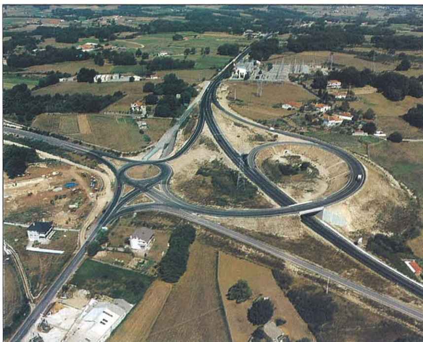
Además de los enlaces, se han construido 3 pasos superiores y 6 inferiores.
