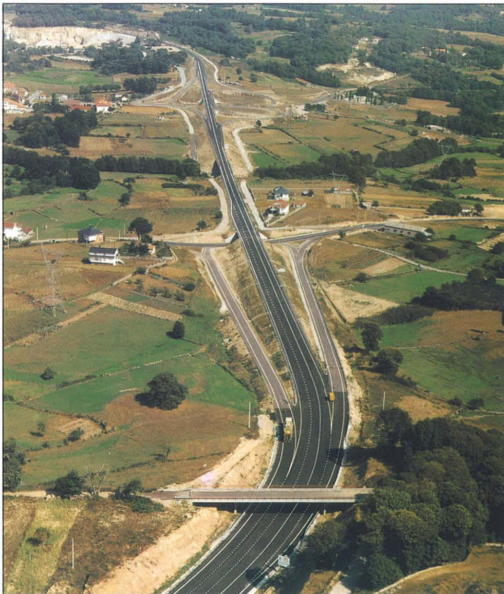
El tramo tiene una longitud de 7 670 m, y se han construido en él un total de cuatro enlaces.
