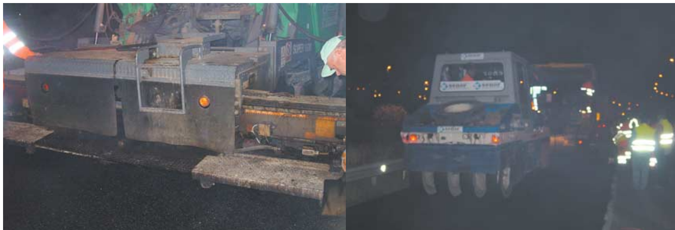
Foto 16. Extensión y compactación del aglomerado sobre la superficie antigua y la manta metálica.
