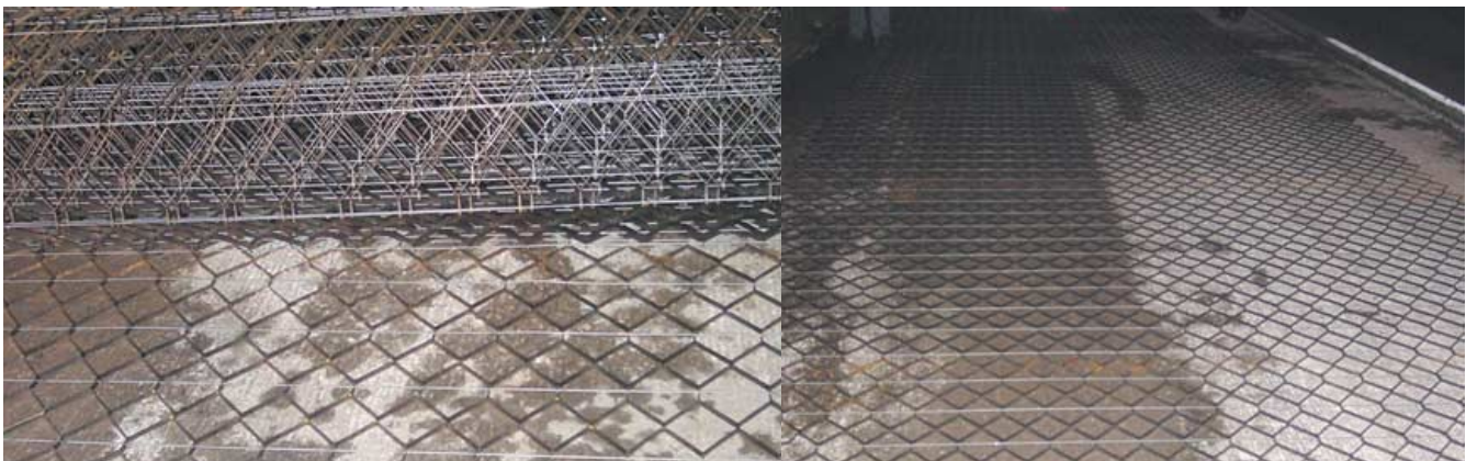
Foto 13 (arriba). Extensión del refuerzo metálico sobre la superficie recién fresada. Foto 14 (abajo). Grapado del refuerzo metálico con pistola de cartuchos de pólvora en un alambre transversal central e inicial. Con flechas se indica el sentido de avance de la entendedor de aglomerado.
