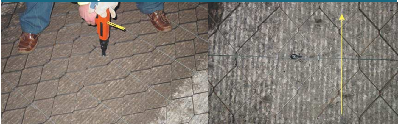
Foto 13 (arriba). Extensión del refuerzo metálico sobre la superficie recién fresada. Foto 14 (abajo). Grapado del refuerzo metálico con pistola de cartuchos de pólvora en un alambre transversal central e inicial. Con flechas se indica el sentido de avance de la entendedor de aglomerado.
