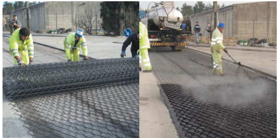
Foto 4. Detalle de la extensión de la malla y riego de adherencia.
