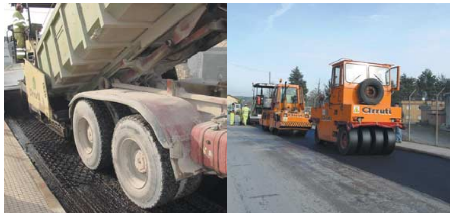
Foto 5. Extensión y compactación del aglomerado de la nueva capa encima de la manta metálica de refuerzo.
