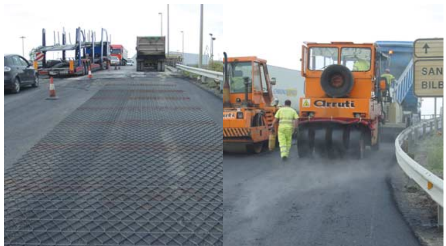
Foto 9. Manta metálica de refuerzo colocada sobre capa de nivelación y compactación de la capa de aglomerado asfáltico colocada sobre la manta metálica previo riego de adherencia.
