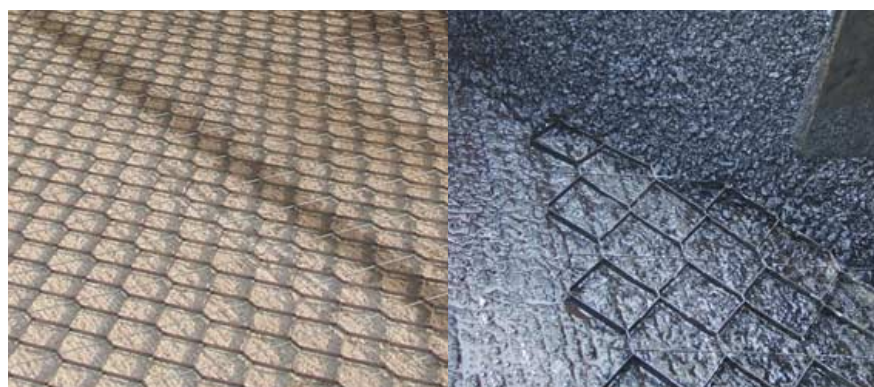
Foto 1. Detalle de la manta metálica de refuerzo del firme al extender el aglomerado.
