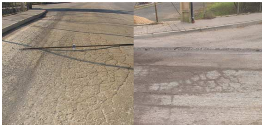
Foto 3. Estado del tramo de prueba de Camargo previo a la colocación del refuerzo y después de fresado.
