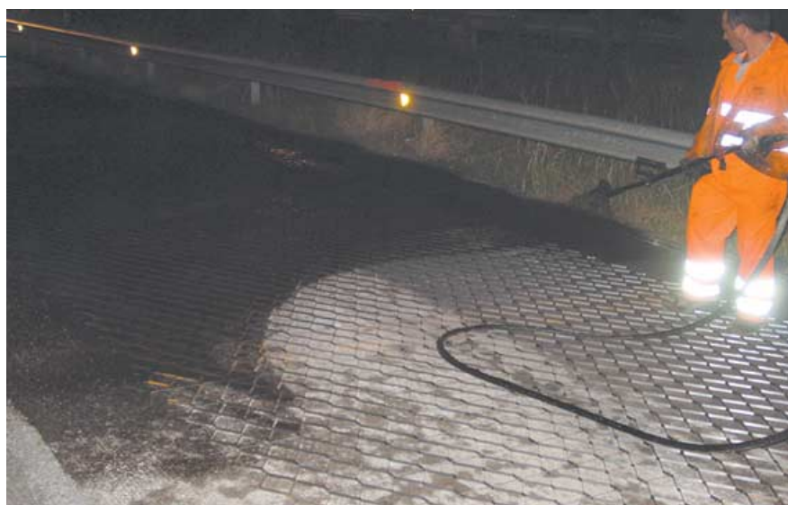
Foto 15. Extensión de la emulsión sobre la superficie antigua y manta metálica.
