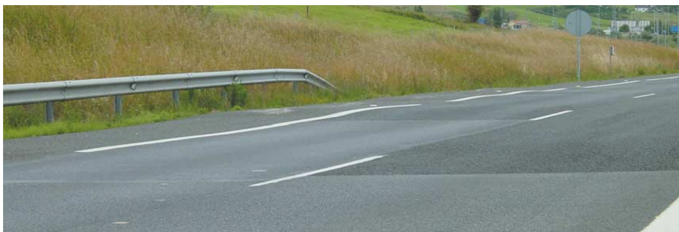
Foto 11. Firme ondulado en la zona del tratamiento.
