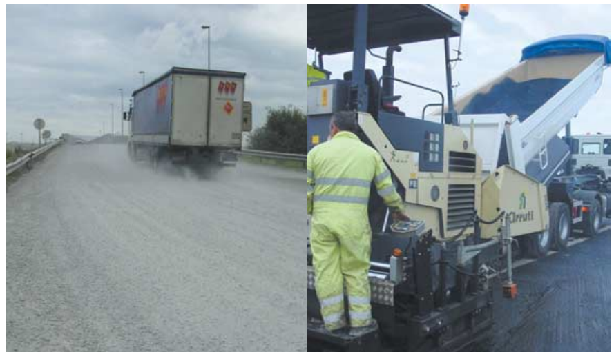
Foto 8: Estado inicial del tramo y extensión de la capa de regularización previa a la colocación de la manta metálica de refuerzo.
