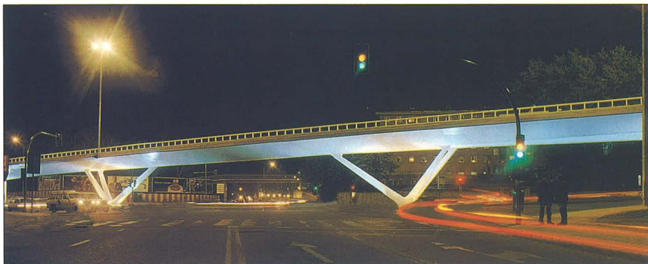
Foto nocturna del nuevo paso elevado.
