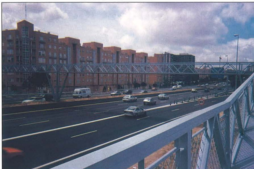
En la foto, se aprecia la pasarela peatonal instalada para cruzar la autovía.
