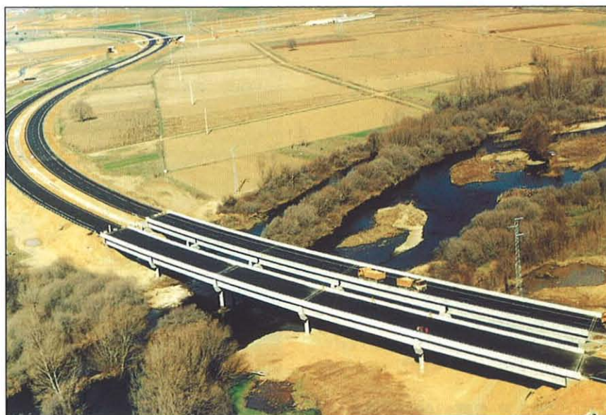
Se construyeron dos viaductos: uno sobre el río Órbigo y otro sobre el arroyo Reguero.
