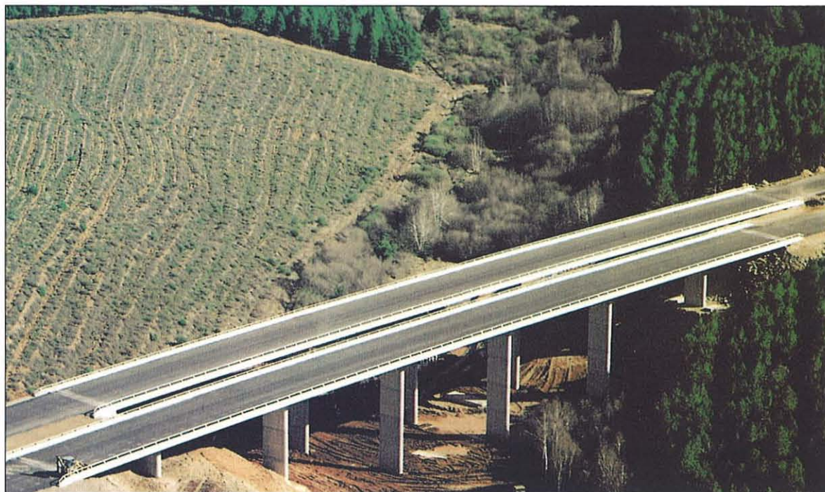
El viaducto está preparado para su ampliación a un tercer carril por sentido de la circulación.
