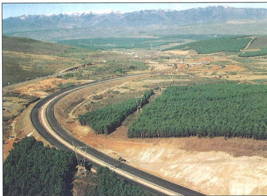
Con estos 18,2 km de este tramo, se han inaugurado de una sola vez un total de 88 km de esta autovía.
