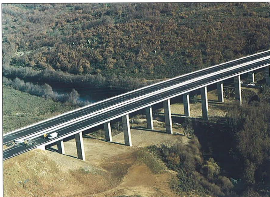
A lo largo del tramo se han construido un total de seis viaductos, destacándose el del río Tera, de 250,8 m de longitud.
