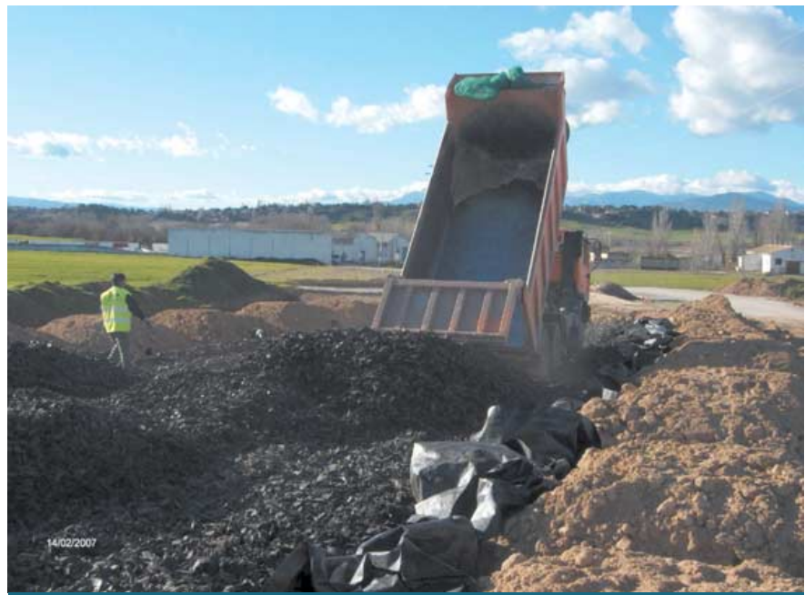
Figura 3. Construcción de la primera capa de NFU triturados.
