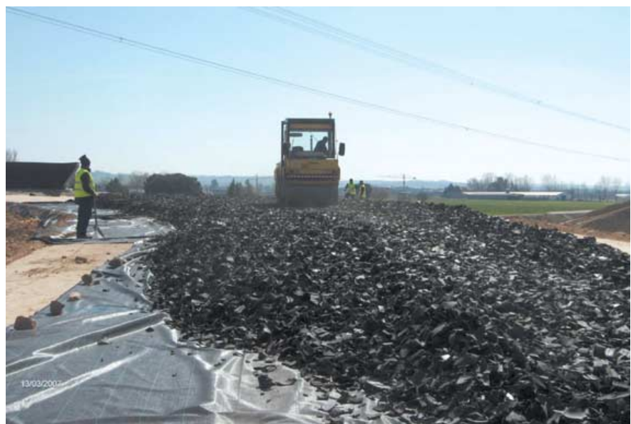
Figura 4. Compactación de la capa superior de NFU triturados del relleno.
