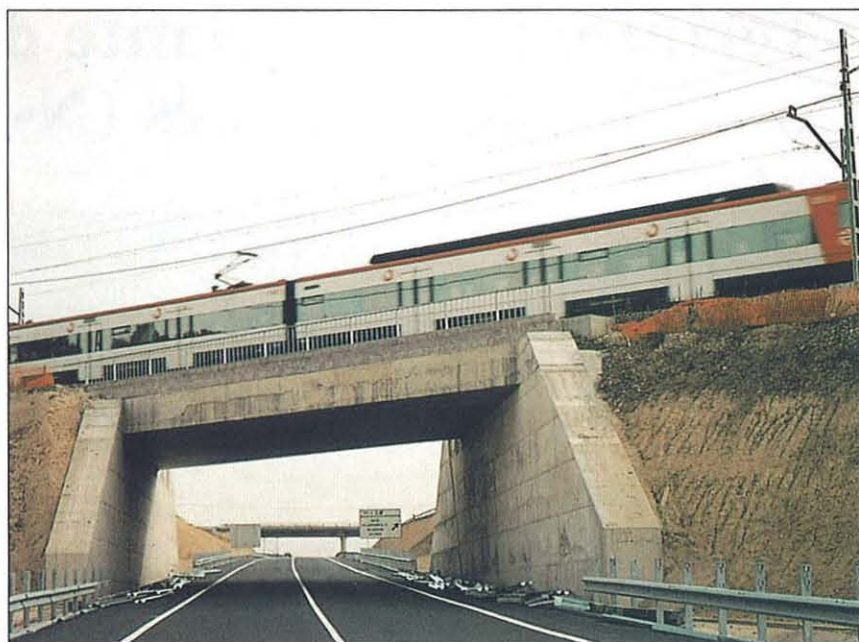
Estructura bajo el ferrocarril de Barcelona a Sant Vicenç de Calders.
