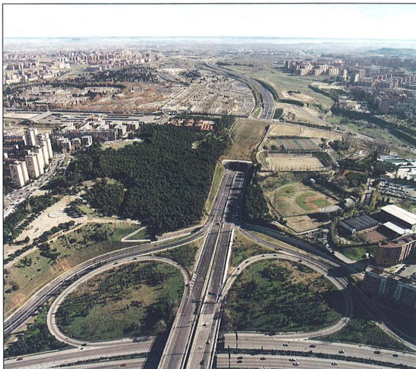
Los túneles tienen una longitud de 360 m.
