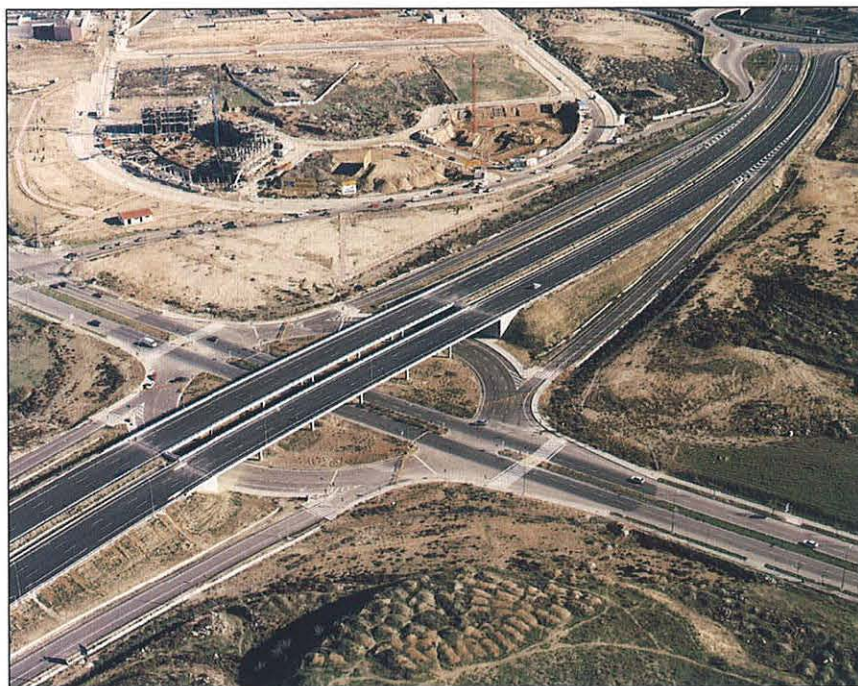
La nueva vía tiene una longitud de 3,3 km en su tronco principal.
