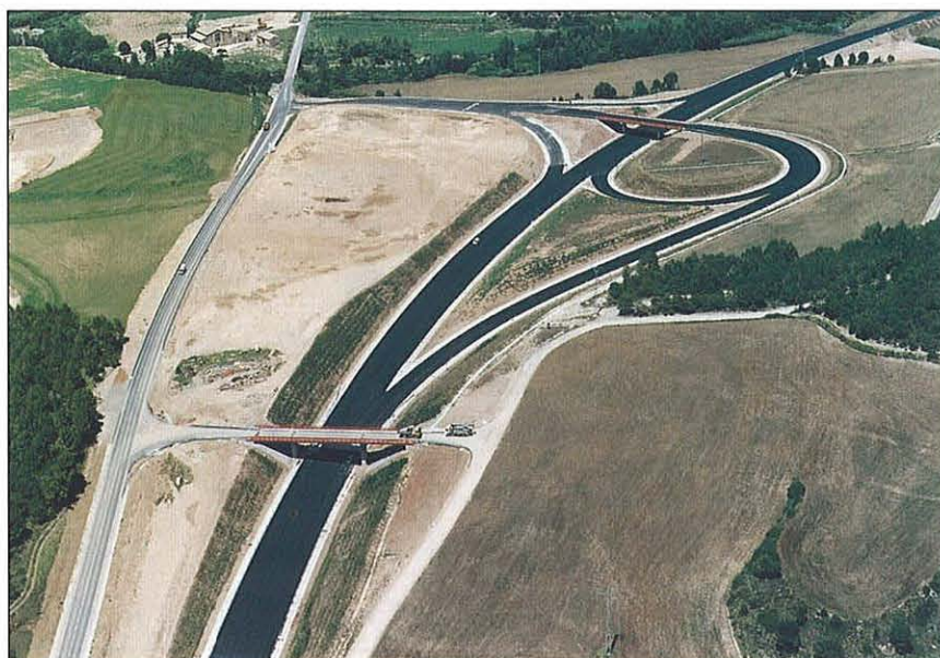
Enlace en proceso de construcción en el tramo Artés - Santa María d'Oló.
