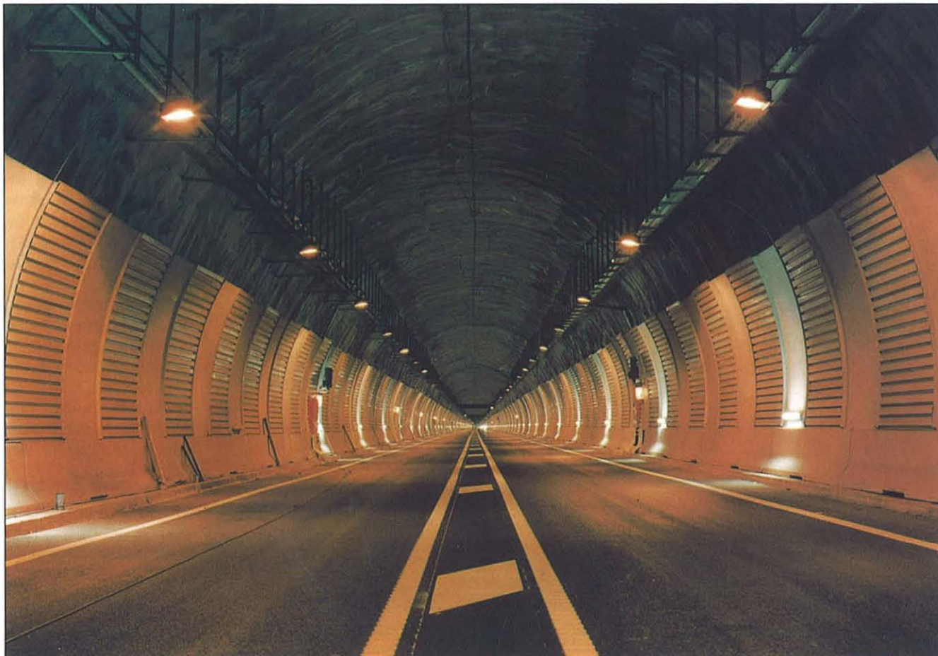
Vista interior del túnel de Velate.
