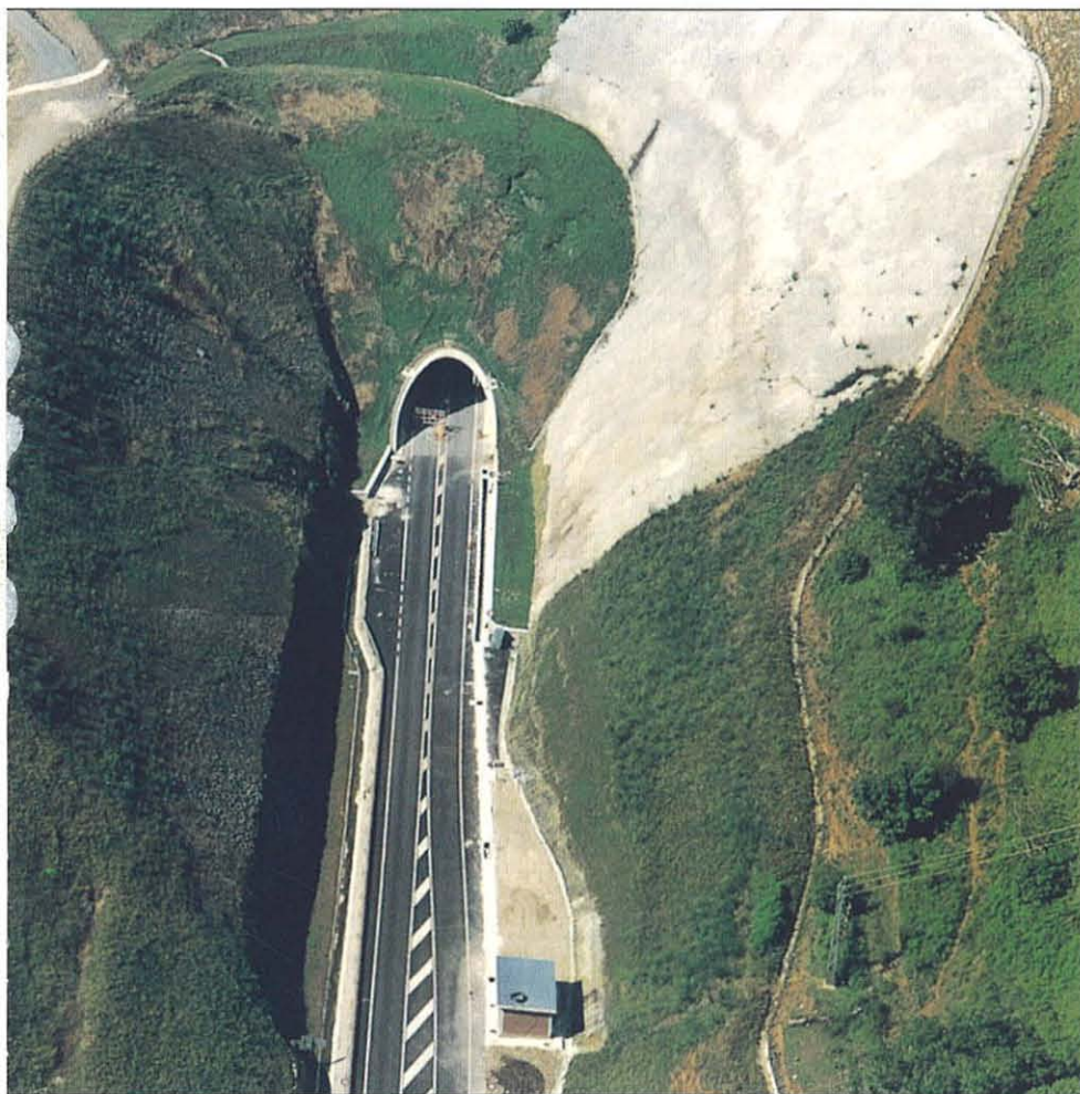
Túnel de Almandotz. Boca norte.
