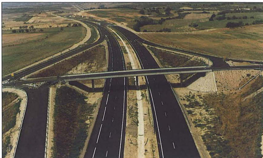
Un total de cinco enlaces se han construido a lo largo del tramo.
