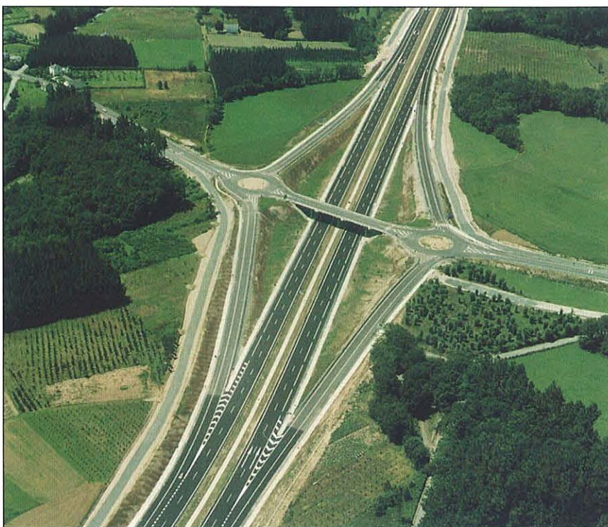
Un total de dos enlaces se han construido a lo largo del tramo.
