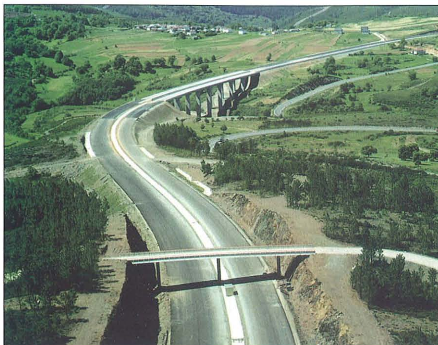
Los viaductos tienen una especial importancia en este tramo. En total, se han construido tres: uno sobre el Riveiriña, y dos próximos a Gudiña.
