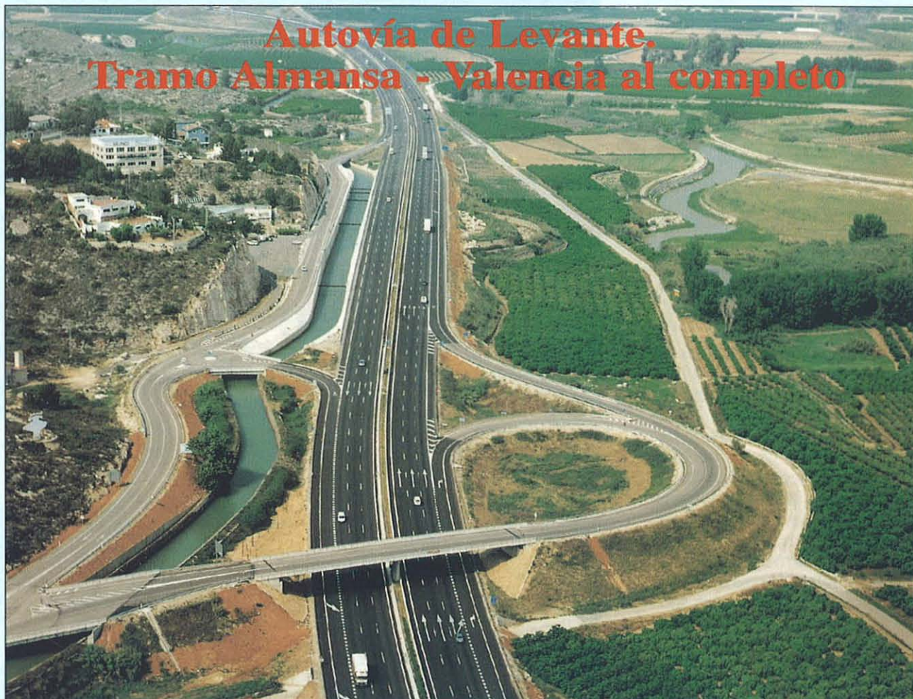
Vista parcial del tramo Xátiva - Silla.
