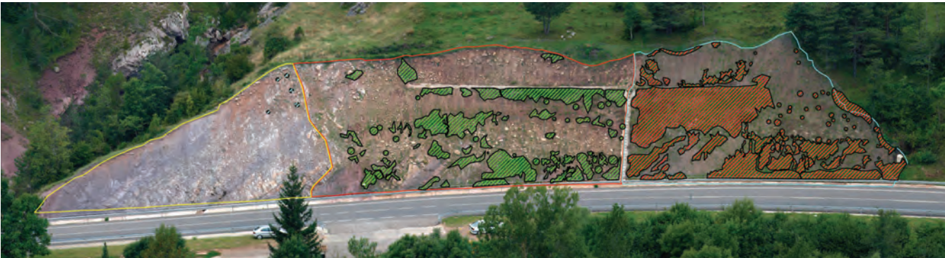
Figura 11. 17/09/08. A los 76 días de la ejecución del tratamiento
