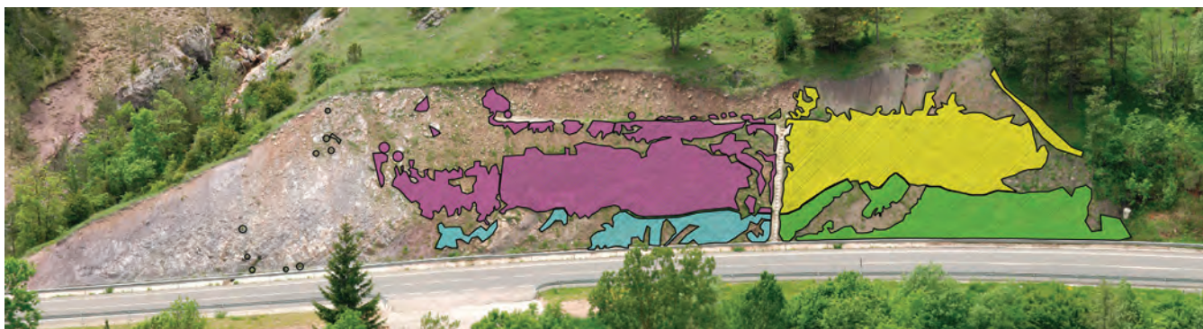
Figura 16. 21/05/09. A los 322 días de la ejecución del tratamiento
