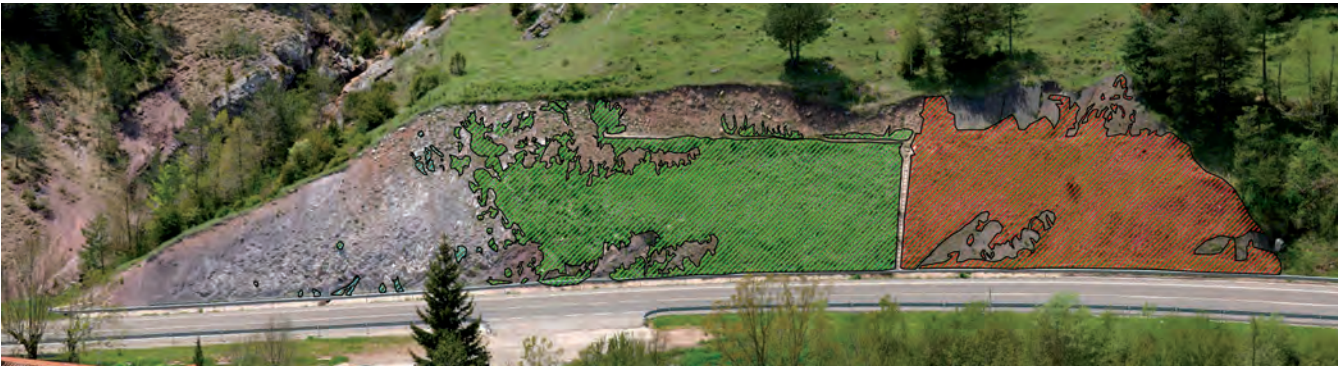
Figura 13. 18/05/10. A los 734 días de la ejecución del tratamiento
