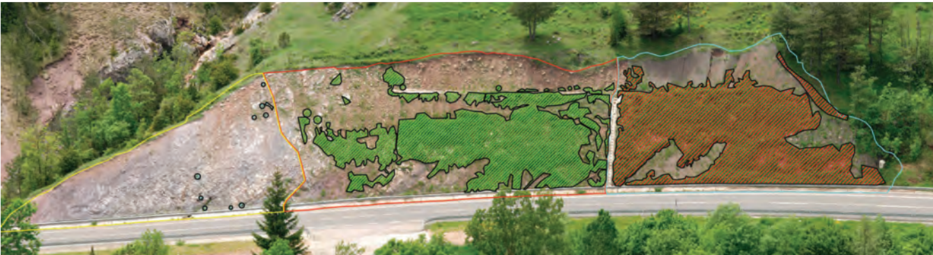
Figura 12. 21/05/09. A los 322 días de la ejecución del tratamiento
