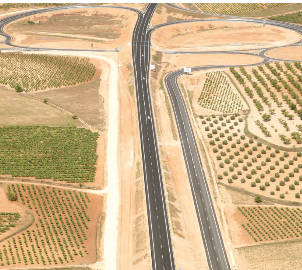
Tronco de variante, p.k. 2+000 a p.k. 3+000 y vía de servicio hacia la AB-880
