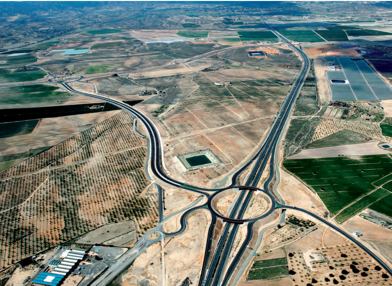
Vista general de la obra en sentido Cartagena-Murcia, con el enlace en el p.k. 164 en primer plano, y el enlace en el p.k. 161, al fondo, con la rotonda de enlace entre el Acceso Norte y el Acceso Sur en el margen izquierdo.
