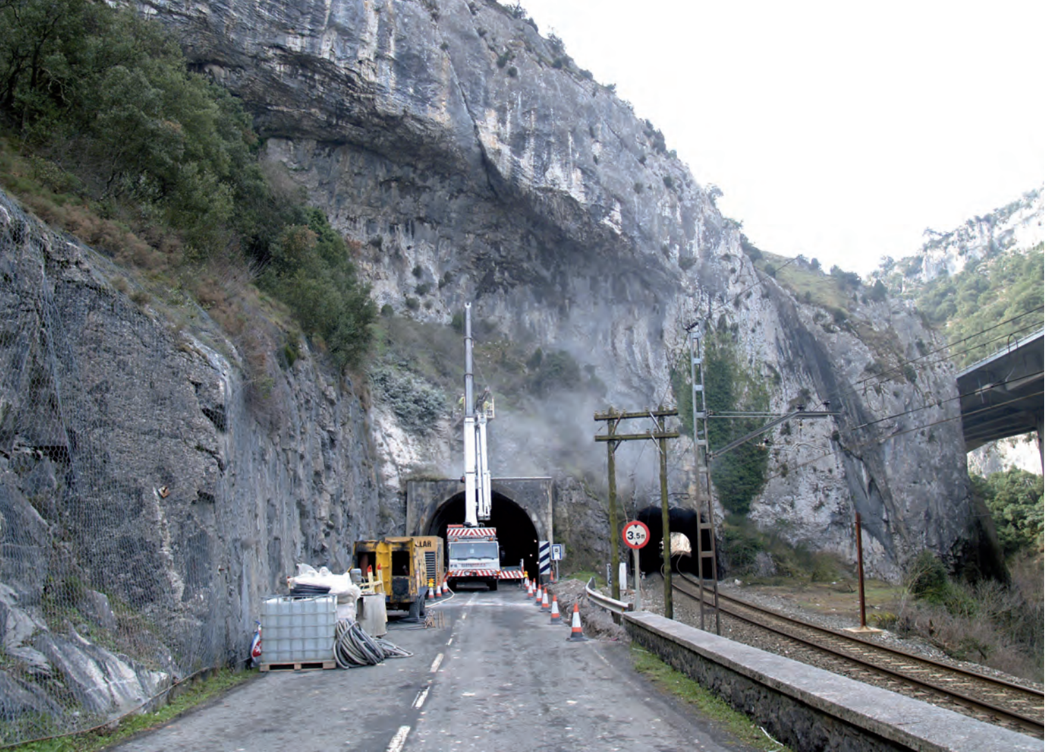
Túneles ferroviario y carretero
