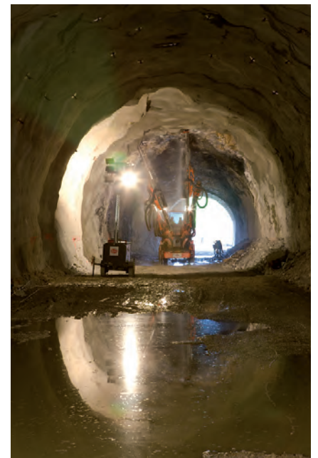
Trabajos de bulonado en el interior del túnel
