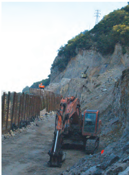
Trabajos de excavación al norte del túnel de Techa
