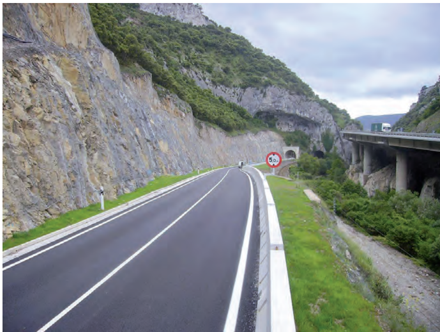
Desfiladero de Techa, una vez finalizadas las obras
