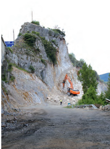
Desmontes en la zona sur del túnel de Techa
