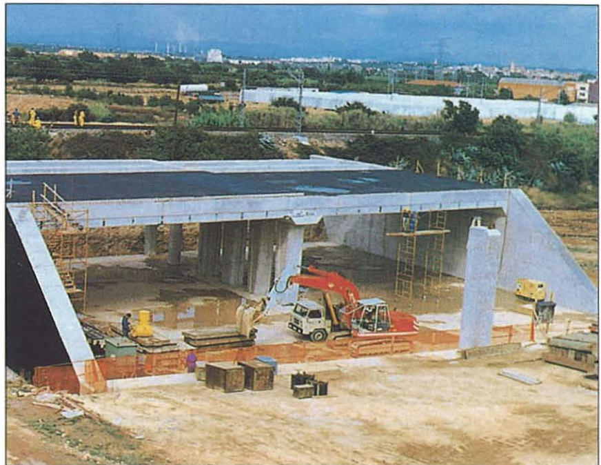
Construcción del cajón de la estructura E-4.2, antes de comenzar el empuje bajo las vías.
