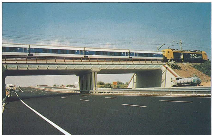
La estructura E-4.2, ya en servicio.
