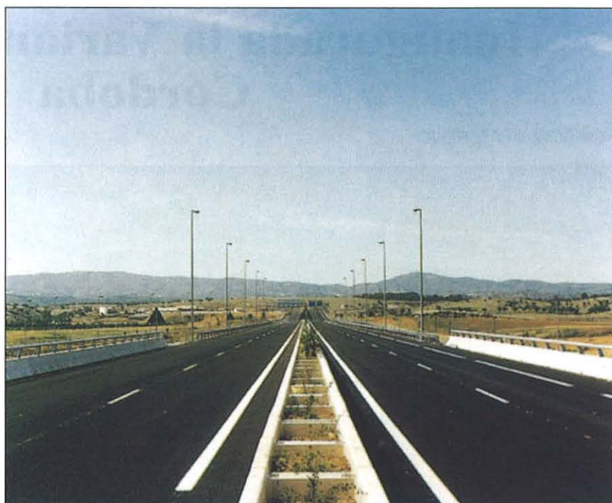
La obra implica una gran mejora de la capacidad de los accesos a la ciudad desde Badajoz y Alcolea, que vienen planteando problemas de congestión en horas punta y fines de semana.
