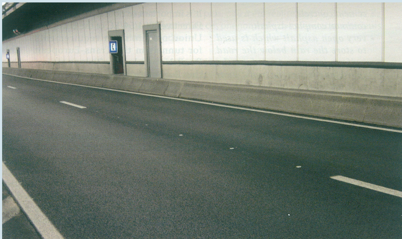
Foto 1. Pavimento bituminoso en el túnel carretero de Belliard en Bruselas, Bélgica.
