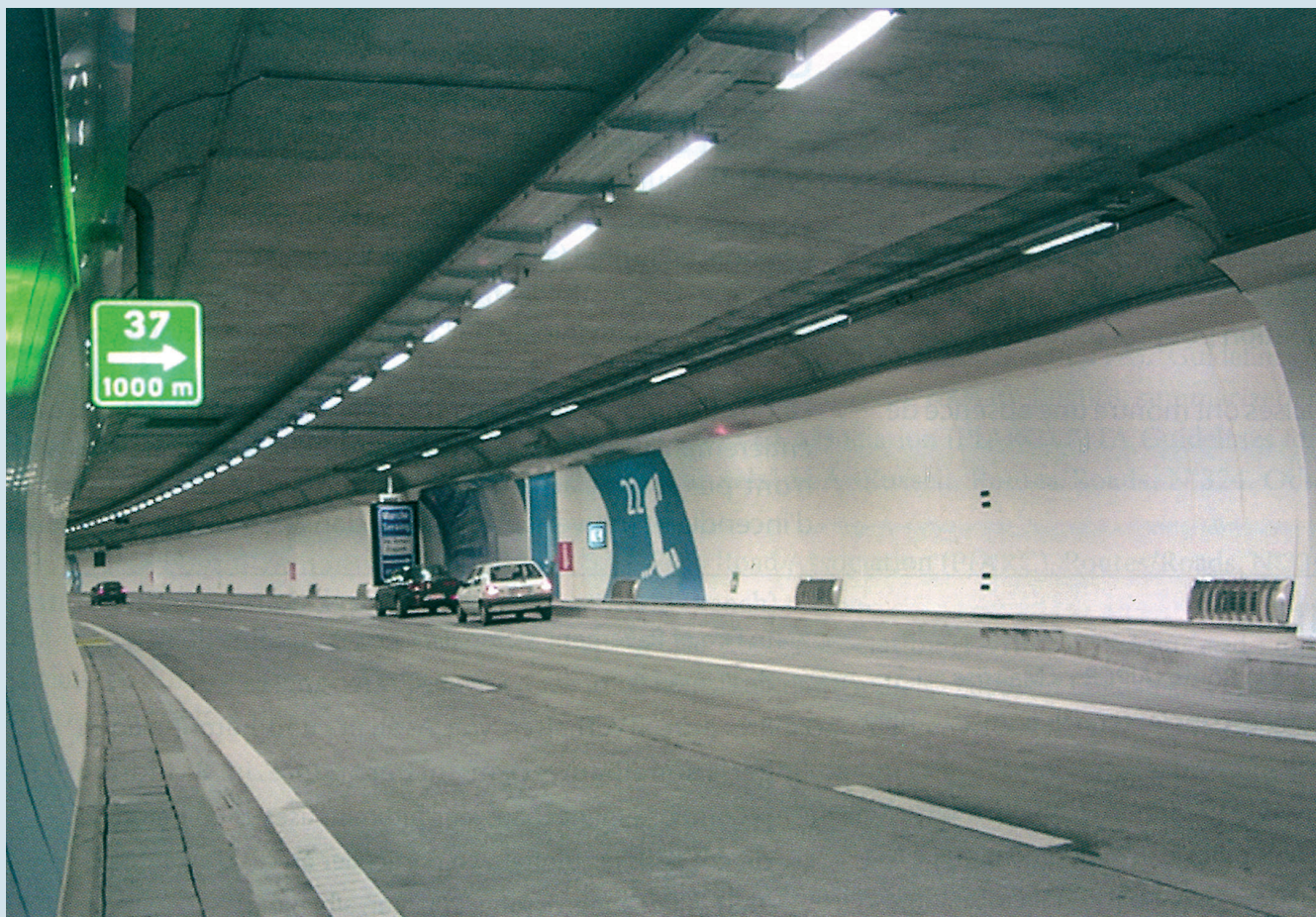
Foto 2. Pavimento de hormigón en el túnel de carreteras de Cointe en Lieja, Bélgica.
