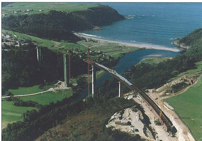
Los viaductos se han realizado con un diseño y unas técnicas de lanzamiento de tablero únicas en el mundo.
