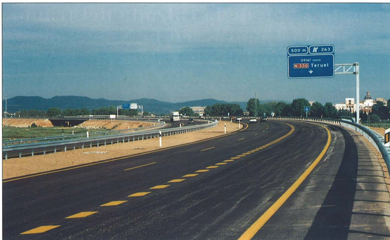
La puesta en servicio de este tramo completa el itinerario entre Caudete y Valencia.
