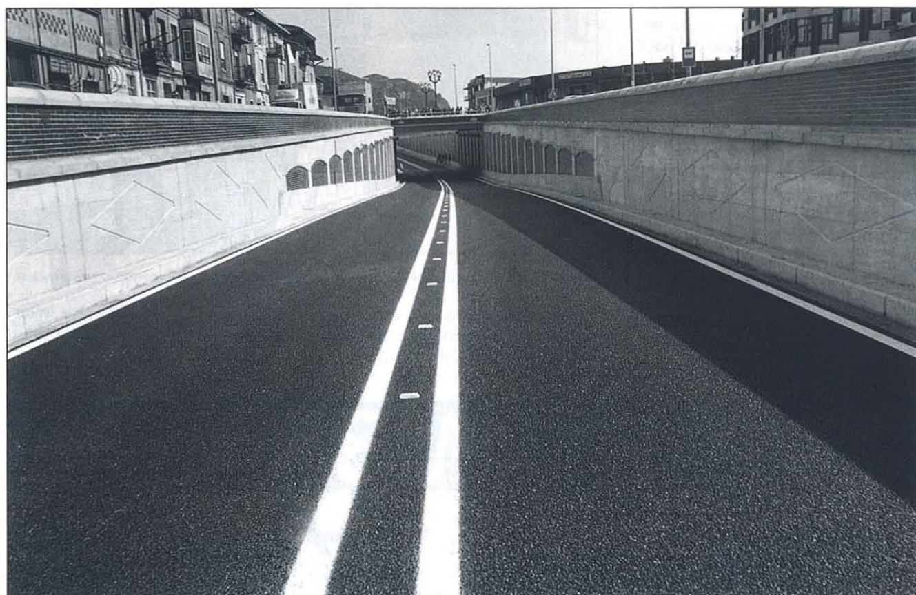
La obra resuelve la intersección de la N-623 con la calle de Primero de Mayo.
