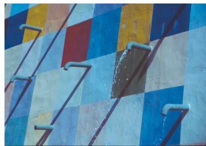
Muro pintado en la Autovía Jaca-Somport.
