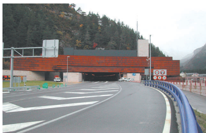
Textura en Boca Sur del Túnel de Somport.
