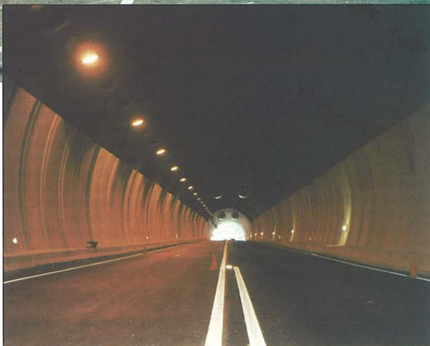
En la foto superior, acceso a la boca sur, donde se sitúa el peaje. La foto inferior, muestra una perspectiva parcial del túnel.
