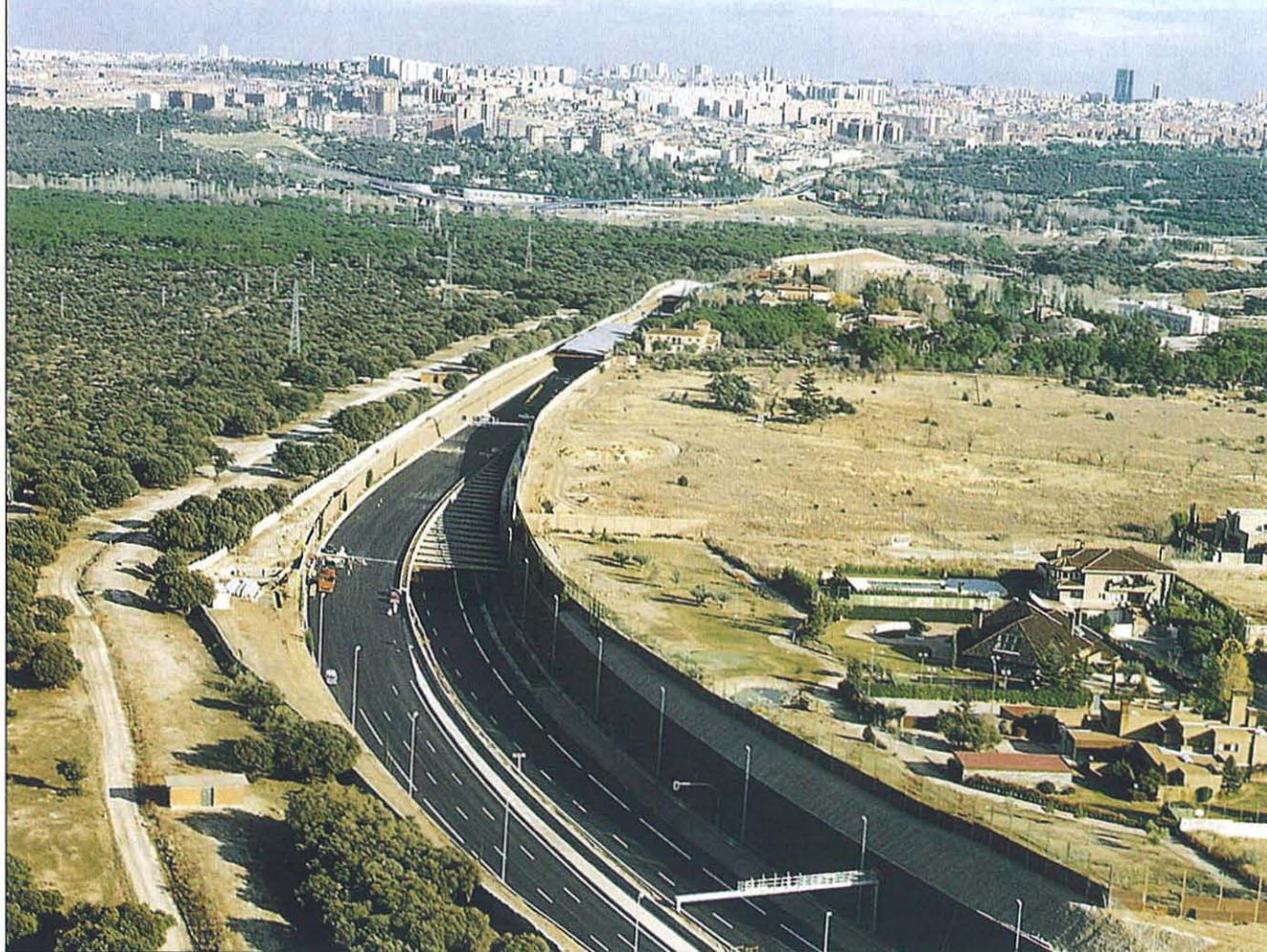
Superposición de calzadas en el distribuidor Norte, tramo I, de la M-40.
