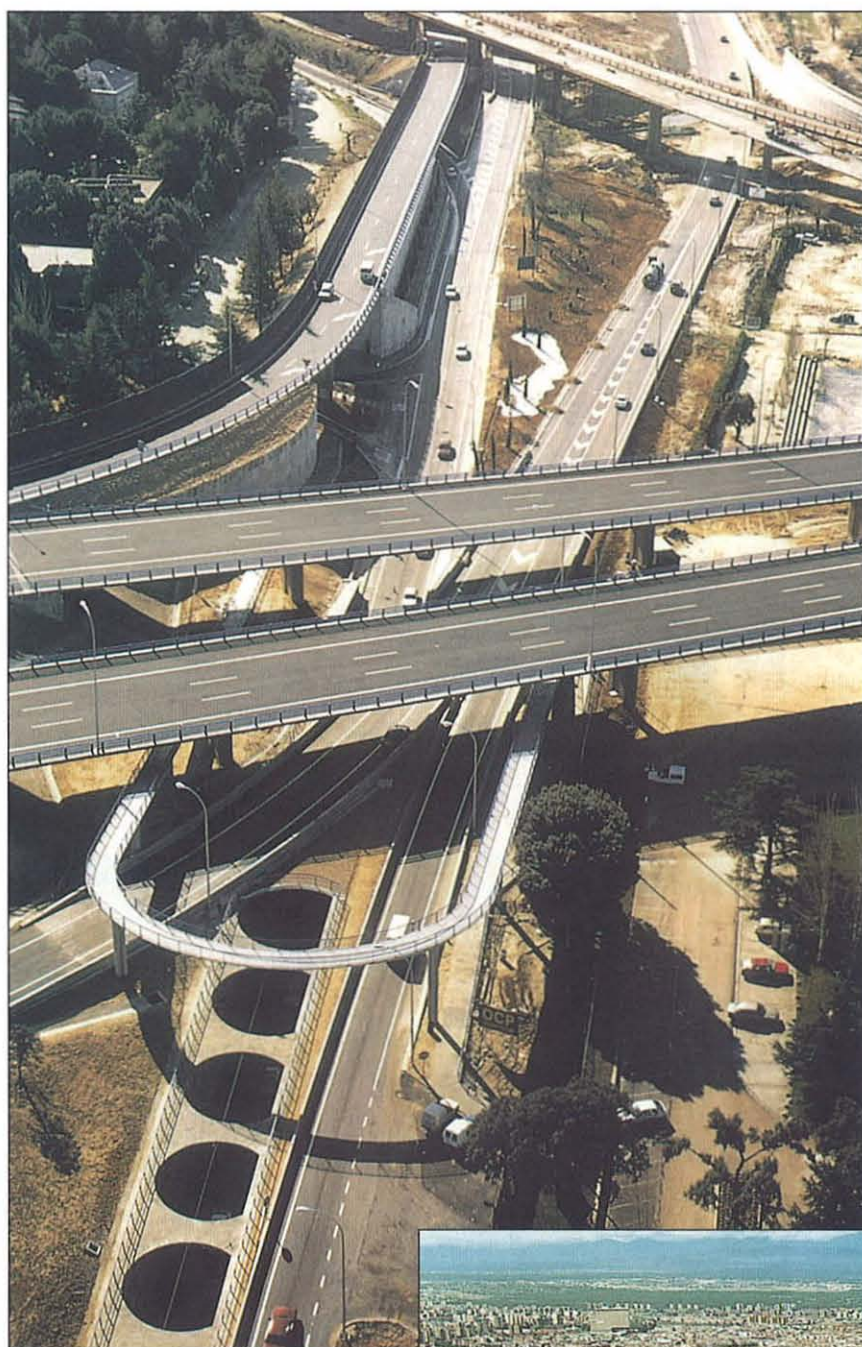
Pasarela para peatones en el Distribuidor Norte, tramo II, inaugurado hace apenas un año.
