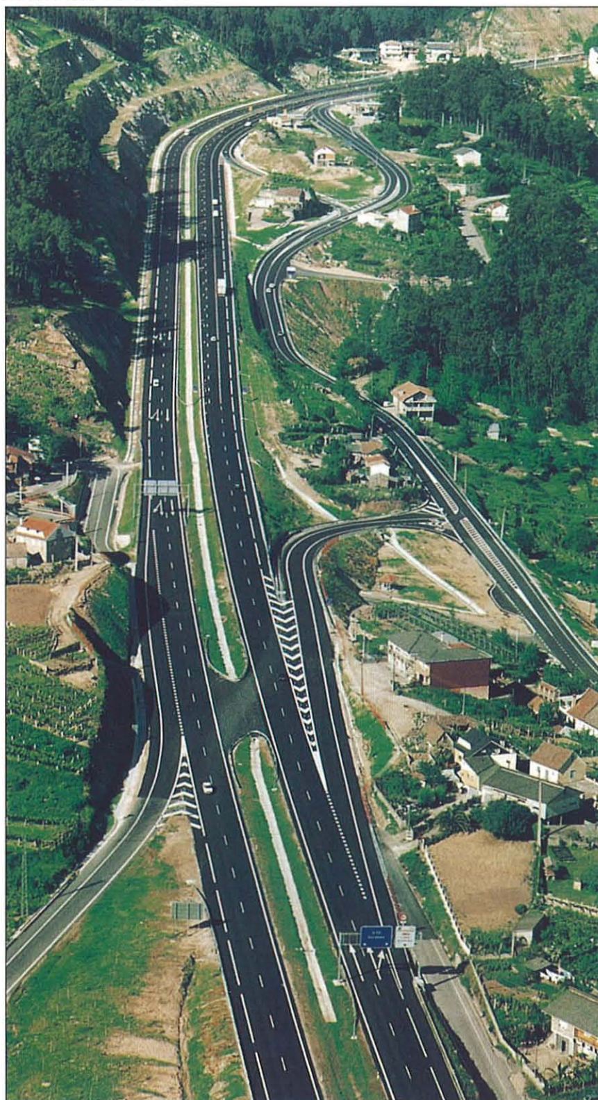
Autovía de las Rías Bajas. Tramo Batallanes-Porriño.
