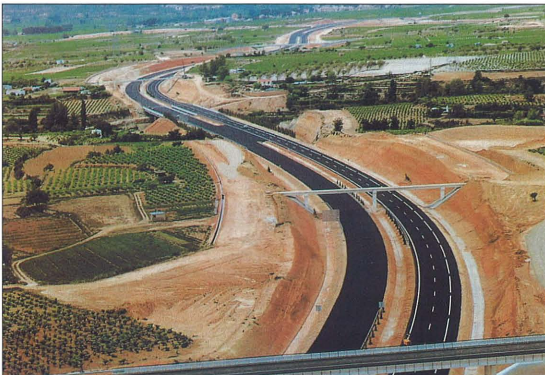
Vista parcial del tramo Caudete-Requena, de la Autovía de Valencia.
